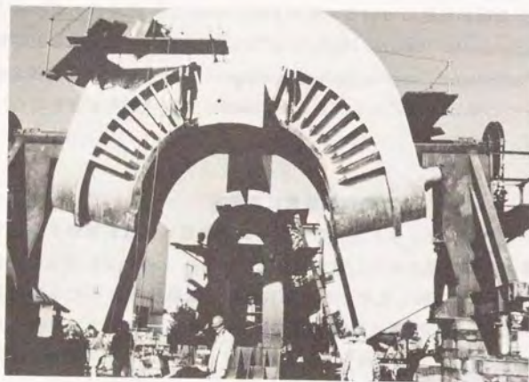
写真7.1 Mirror Fusion Test Facility用の陰陽コイル（組み込み前）。
