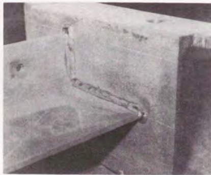
図5-7 アングル材の溶接施工例
