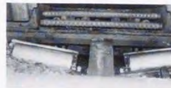
写真 6.2 TDCロールの組み込み状況 (圧延機出口より)
