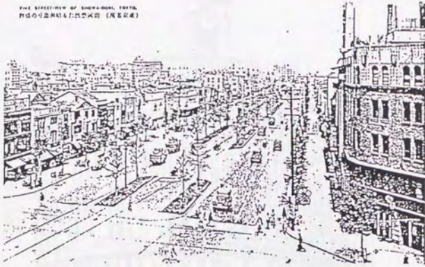
写真 3. 3. 5 街角の剪除 (昭和通り)
