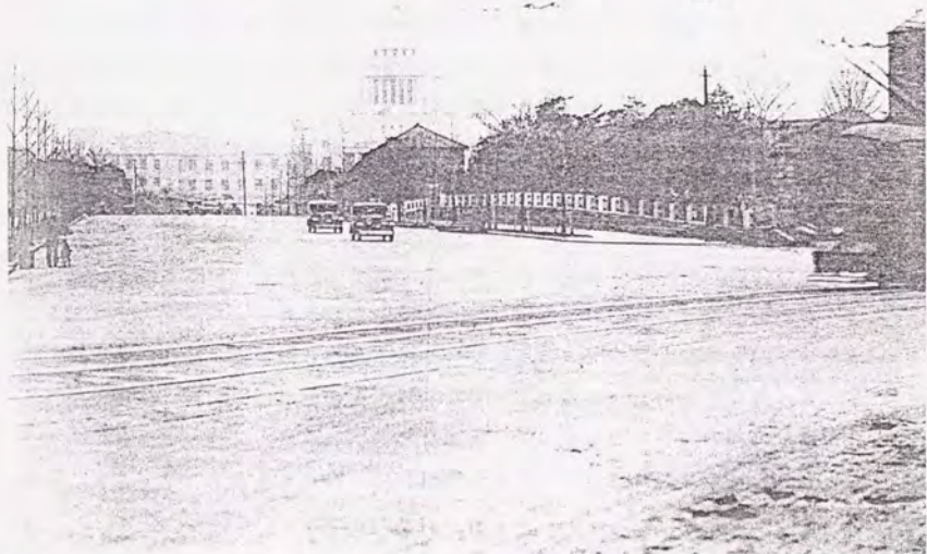
写真3. 3. 3 (明治四十二年) 東京市議院新築工事現場外門前 東京市第八路街
