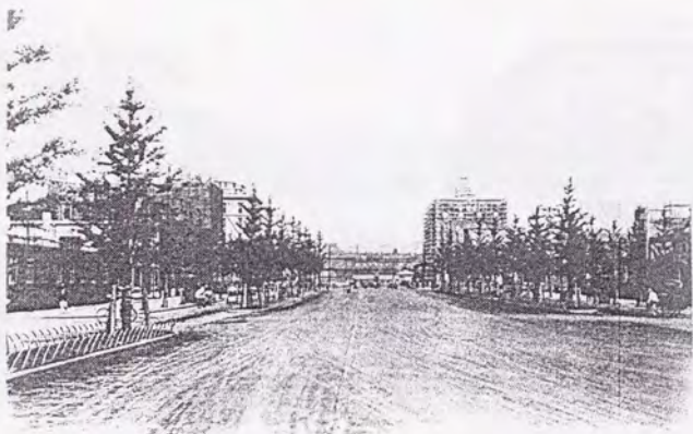
號七第路街線幹京東 (月八年四和明) む望を前方驛京東りよ路小廣橋中後功竣事工
