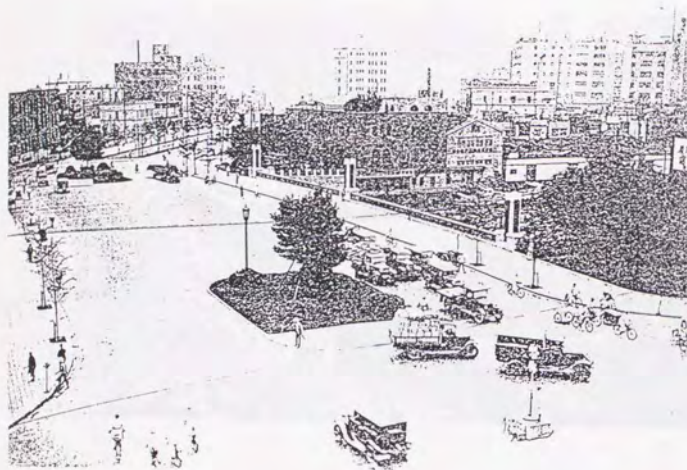
写真3. 3. 8 昭和通江戸橋付近
