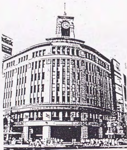
服部ビル外観
