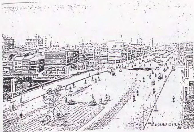
写真3. 3. 7 昭和通江戸橋付近
