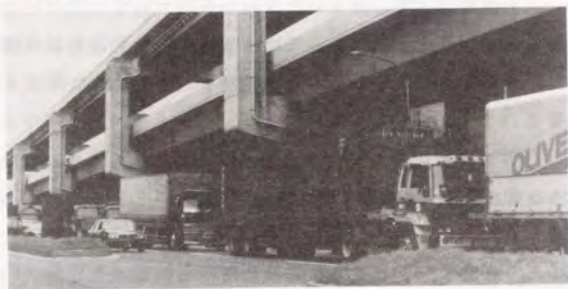
写真4-1 コンテナ車と積み替え輸送車両で埋め尽くされた臨海部道路 平成5年度著者撮影，大阪港南港付近
