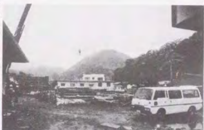
隣接する小規模特養の建設現場 渡り廊下で接続
