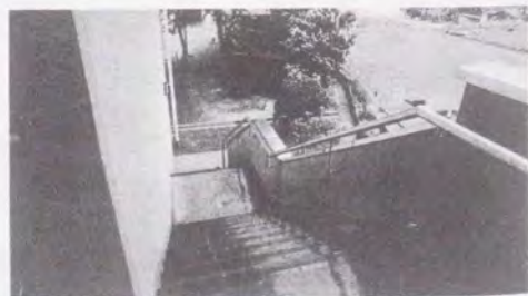
非常階段 非常階段付近より南方向を望む
