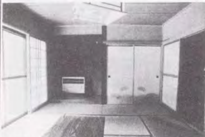
2人室用居室、冷房設備が床の間に設置されている
