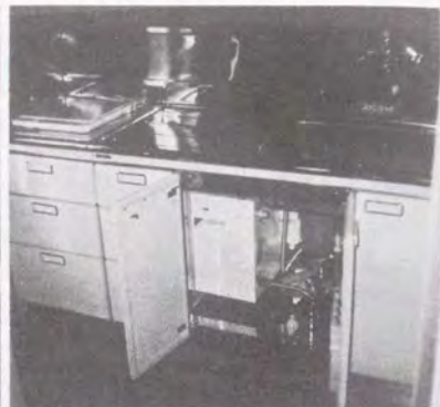
居室、キッチン 電気給湯器設置
