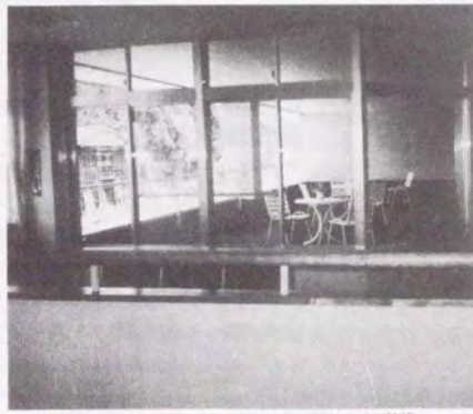
2階バルコニー、将来的には集会スペースを増設
