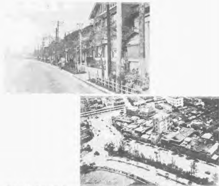
図 3.2.42: 幹線街路 52 号線・上野不忍池脇の街路の植栽: 上[119], 下[107]
