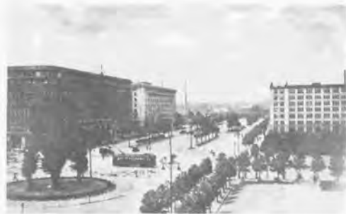
図 3.2.5: 東京駅前広場の植栽と行幸道路 [93]
