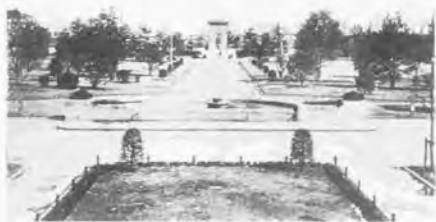
図 3.2.19: 竣工当時の浜町公園 [118]
