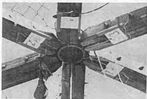
写真5.1.2 接合部のねじれ座屈
