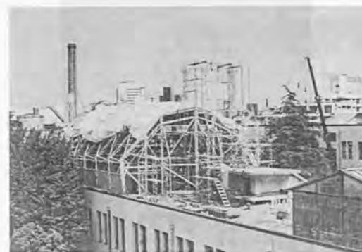
写真3.4.5 膜の施工
