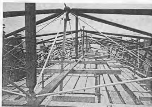
写真3.4.3 ケーブル材設置
