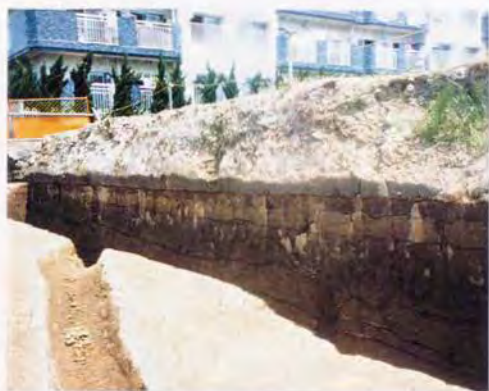
写真V-1 大野田水田土壌断面
