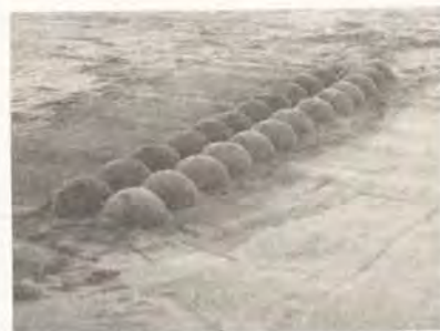
図3-17 人工凹凸（半球）
