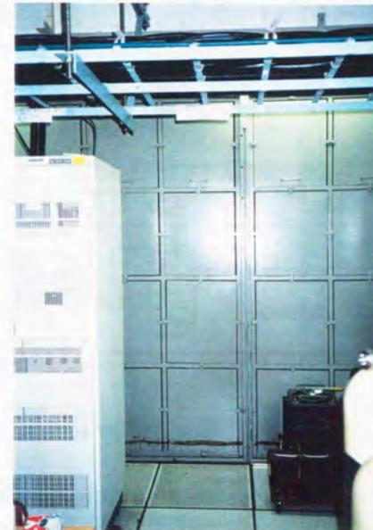
図-1-7 壁(着/脱)パネル
