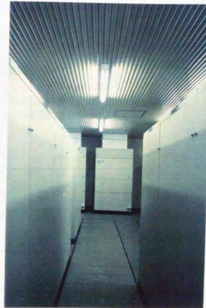
図-4-7 天井の構成例：スリット天井
