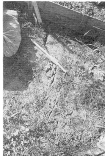
Fig. 11. En echelon cracks at Loc. 3.
