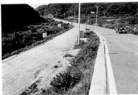
Fig. 24. Damage to road on the fault line at Loc. 18. (N. Nakagi).
