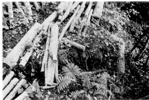
Fig. 23. Crack at Loc. 17.
