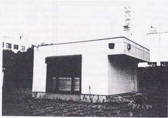
図 8.3 南東からみた実験棟概観
