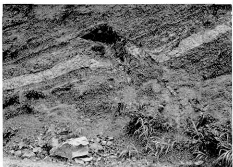
Fig. 6 新潟県勝木八幡山切通しにおける断層からの落石
