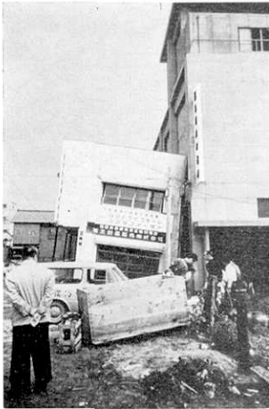
第10図 新潟市内で隣の鉄筋のビルにつられて傾き破壊した建物。
