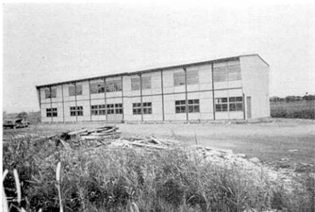
第11図 新潟市小針で周囲が相当被害をうけているのに健全だった鉄骨校舎。
