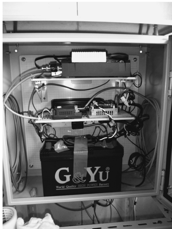
図 12. 工作室内の局舎 (キャビネット) 上段からテレメータユニット, LF-1100R, CAN 通信用避雷器, LVD1224 (12V から 24V への昇圧), バッテリー充電器 BP1210, G&Yu 社製 105 Ah 鉛蓄電池, アースは工作室の庭にアース棒を 3 本打ち込んだ.
