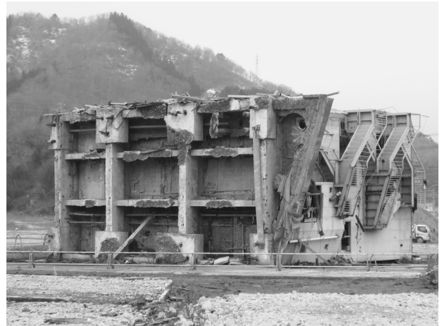
図 6. 横倒しになった鉄筋コンクリートビル
