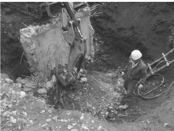
図 5. 半地下観測室の撤去状況（解体作業の終盤）
