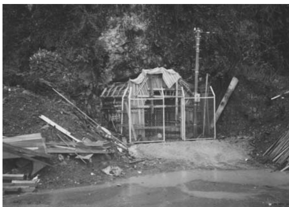
図 10. 壕入口斜面の崩落防止のアーチ状防護壁の施工状況
