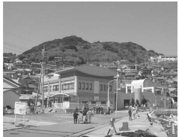
図 29. 南東側斜面の密集住宅で斜面崩壊と倒壊被害多数
