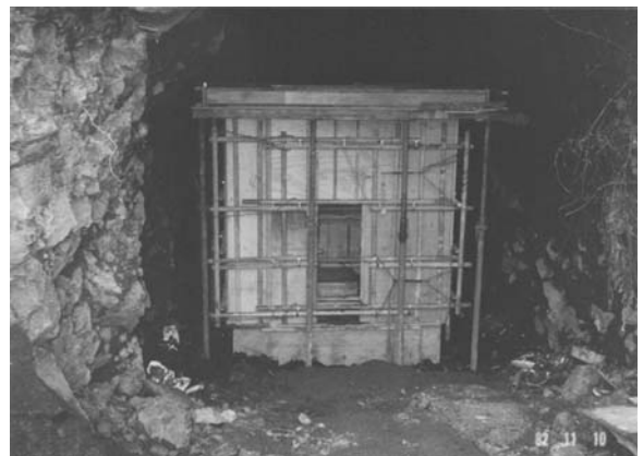
図 9. 壕入口から約10m先の壕内局舎施工の状況
