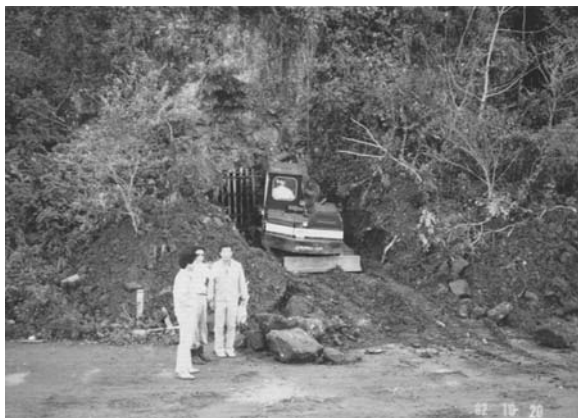
図 8. 観測点設営開始の壕口盛土と鉄格子の除去状況
