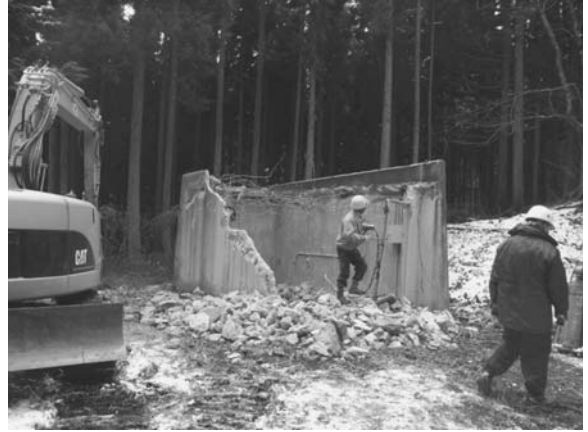
図 2. 解体撤去中間段階の状況
