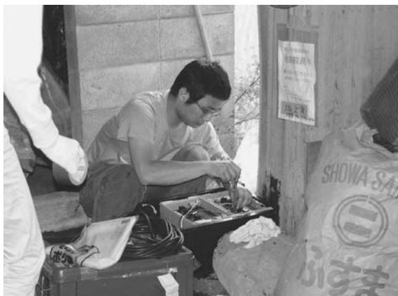
図 32. 一関市巖美町民家物置での地震計設置状況
