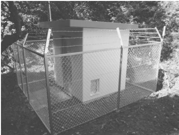
図 40. 大井町赤田観測点の営繕整備完了状況
