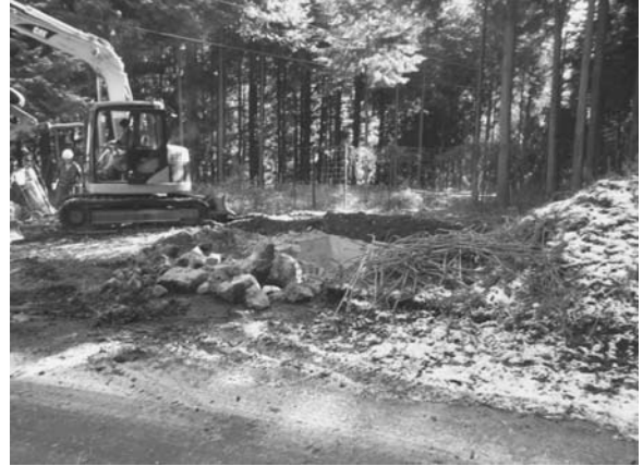
図 4. 上屋局舎解体撤去後の状況
