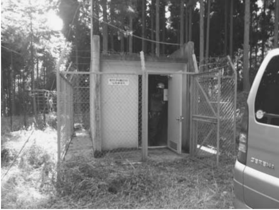
図 1. 解体撤去前の松田寄観測点の現状
