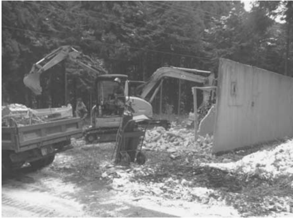
図 3. 解体撤去後半頃の状況
