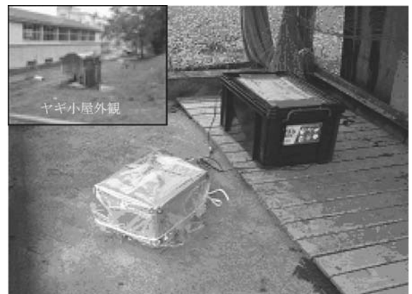
図 27. ヤギ小屋に設置した機動型強震計:右バッテリー
