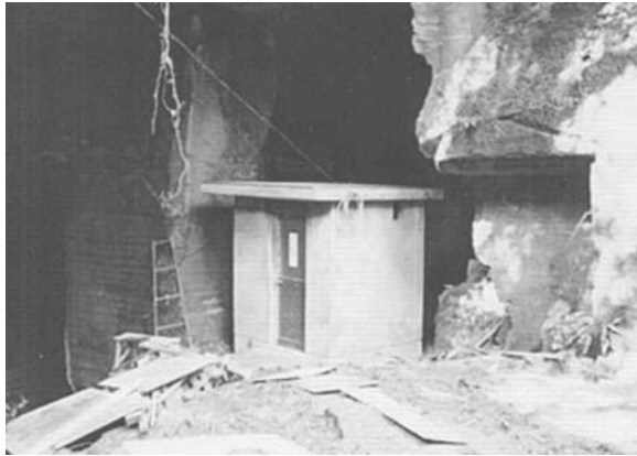
図 6. 施工途中で型枠を取り外した状況
