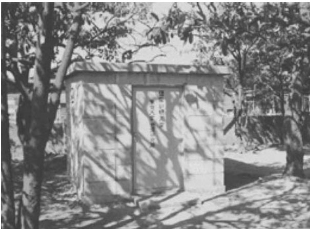
図2. 初めて局舎建設を伴った江東観測点（都立猿江公園）（幅1800×長1800×高1800mm）
