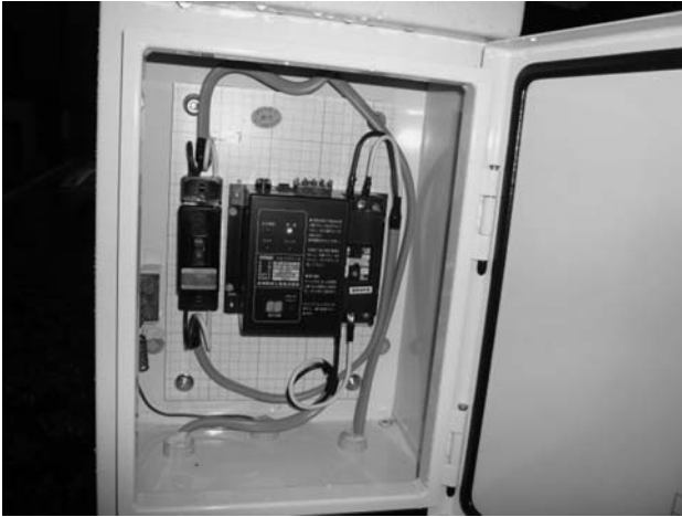
図 7. 引込柱に設置されたリミッタ（左）とリセットブレーカ（右）
