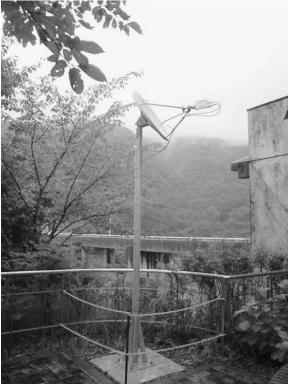
図 12. 完成した衛星パラボラアンテナ。
