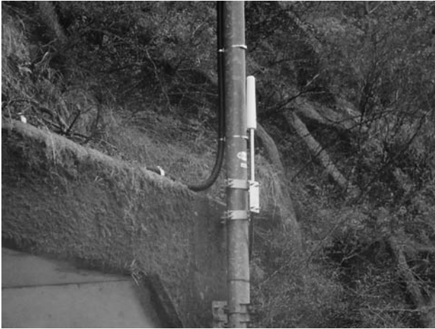
図 8. トンネル坑口外の既存テレビアンテナ柱に設置した GPS アンテナ。
