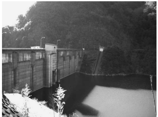
図 3. 広渡ダム堤体。北側から望む。
