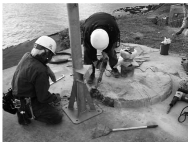
図 28. モジュール支持支柱のケミカルアンカー固定準備
