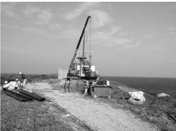
図 18. ボーリングマシンの据付状況とケーシング管（左）
