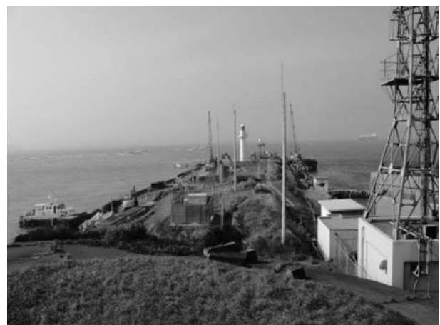
図 47. 右側鉄塔監視カメラと保安庁消防訓練施、左側工事資材運搬用の引き舟、後方護岸工事の作業状況と灯台
