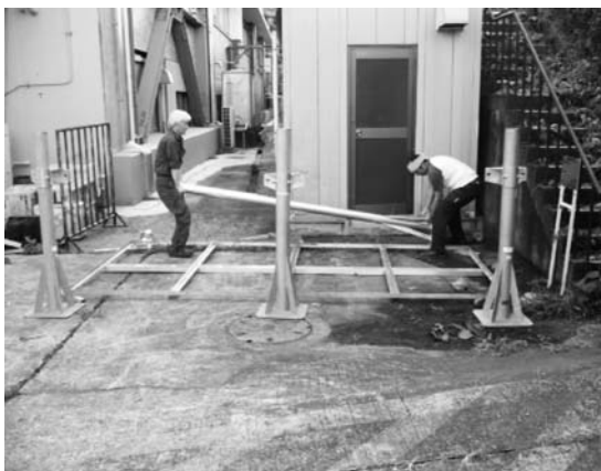
図 11. 太陽電池モジュールの事前組立（地震研車庫横）
