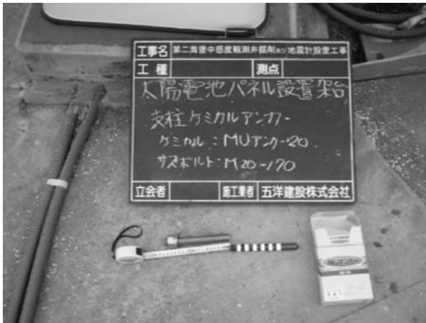
図 29. モジュール支持支柱固定に用いたケミカルアンカー
