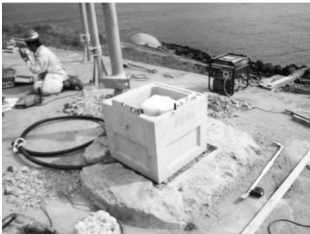
図 31. ボーリング孔口の保護升取付け状況
