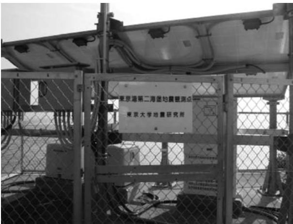
図 50. 完成後のフェンス扉に看板取付け状況
