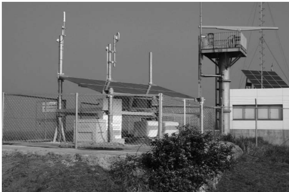
図 53. 東京湾第二海堡に完成した地震観測点の外観：左上部 GPS, 中央上部無線 LAN アンテナ
