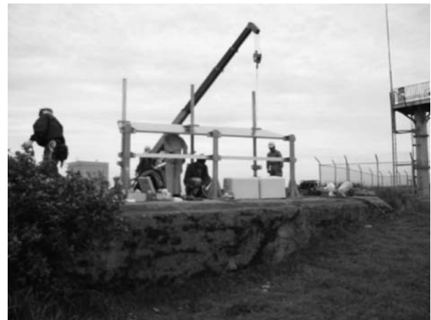
図 32. 支持支柱への太陽電池モジュールの取付け状況
