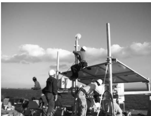
図 33. パネル支柱上への無線 LAN アンテナ取付け状況
