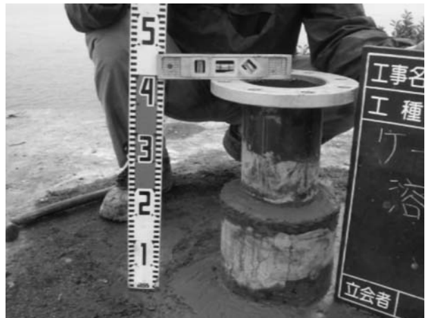
図 25. 完成したボーリング孔口にフランジ溶接状況
