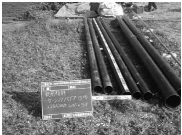
図 19. 搬入した5インチケーシング管と8インチ管（右）
