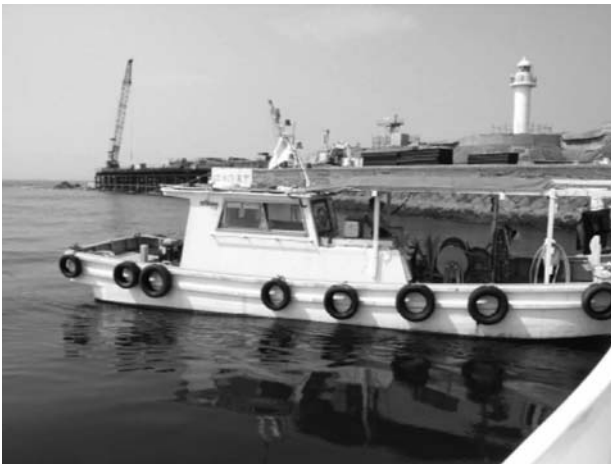
図 22. 急遽乗船し第二海堡に着岸。後方工事用大型重機と灯台
