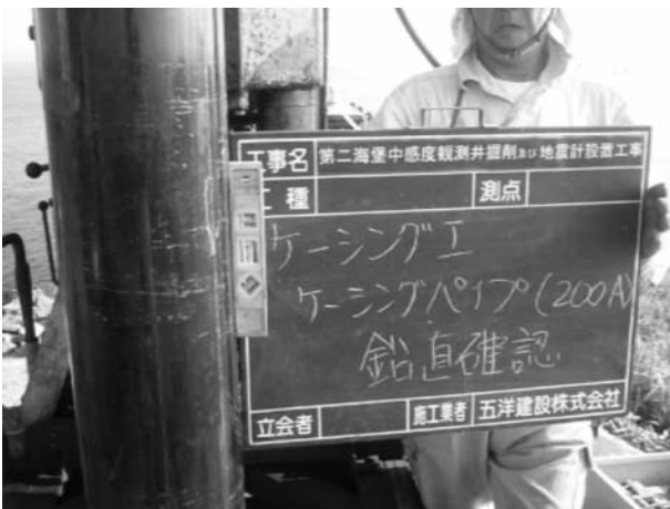
図 24. 地震計埋設用ケーシング管挿入時の鉛直確認
