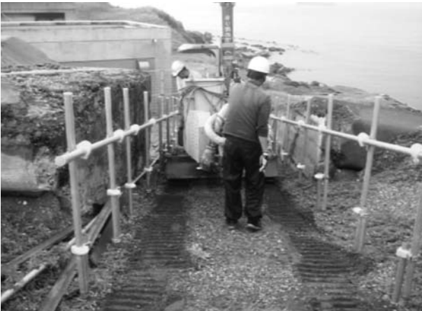
図 16. 小型キャタビラ付重機で機材・資材の輸送状況
