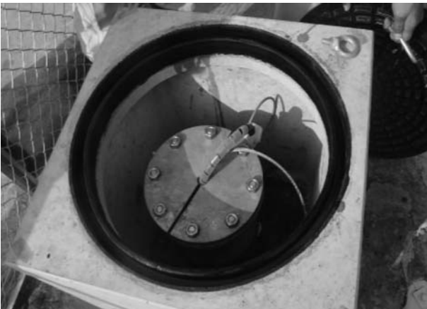
図 43. 地震計埋設完了後の信号ケーブル固定状況
