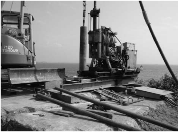
図 20. ボーリング掘削開始状況。掘削 8 インチビット
