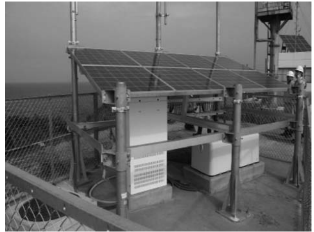
図 49. 太陽モジュール 8 枚，収録装置・バッテリー取付け状況
