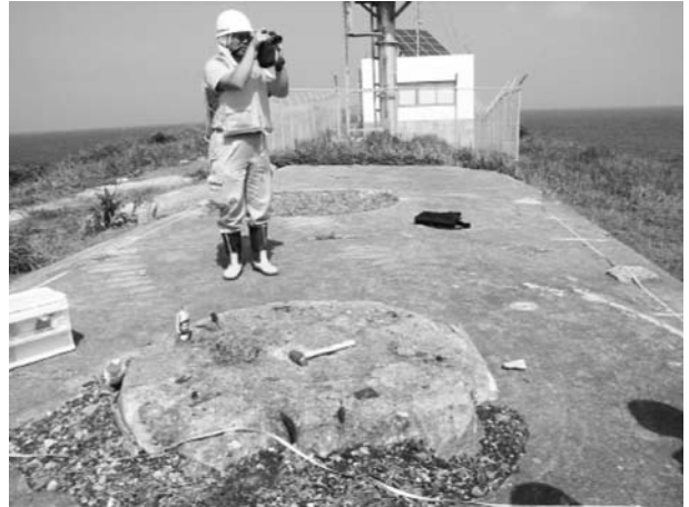
図 17. 手前コンクリート円形状ボーリング掘削地点
