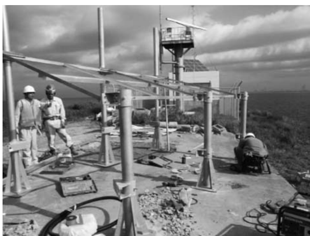
図 27. 太陽電池モジュール固定枠・支持支柱取付け状況
