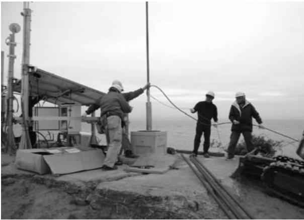
図 41. ボーリング孔への地震計埋設開始状況
