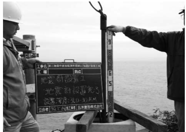
図 42. 地中地震計埋設完了状況(設置深度 30.16 m)
