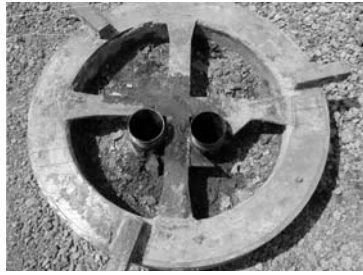
2005.4 埋設完了した基礎杭と保護管
