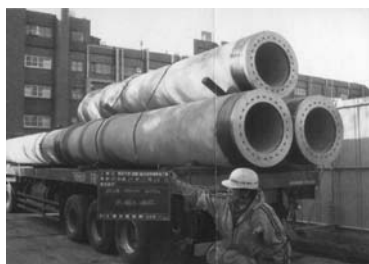
2005.3 基礎杭搬入状況と接続面
