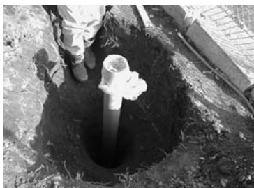
2005.9 検出器埋設用塩ビ管径 100φ
