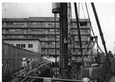
2005.3 基礎杭の接続状況と保護管
