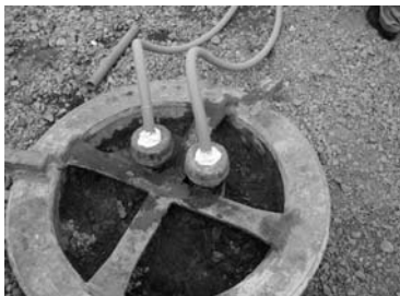
2005.4 検出器埋設完了と信号線
