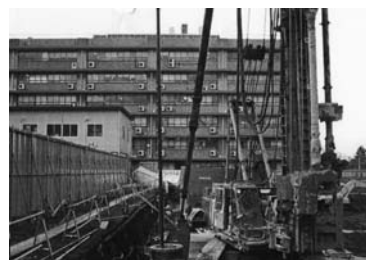
2005.3.検出器保護管の接続完成
