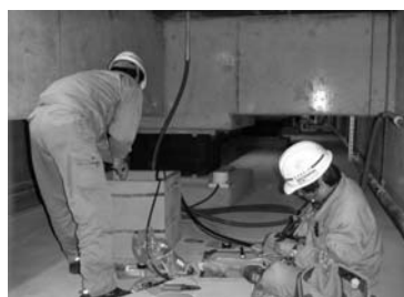
2006.3 免震地下ピットの信号線接続
