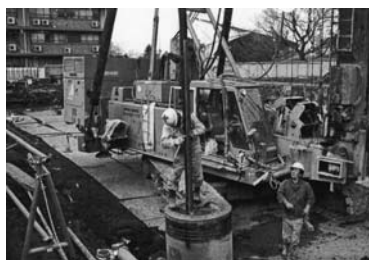
2005.3 検出器保護管の溶接接続状況
