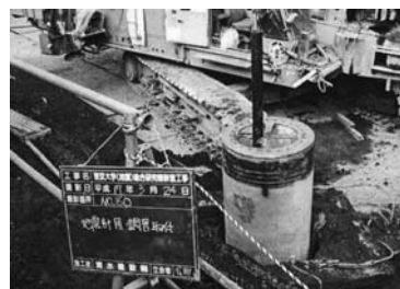
2005.3 基礎杭の埋設と保護管抽入
