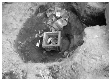
2005.9 検出器埋設塩ビ管の孔口保護
