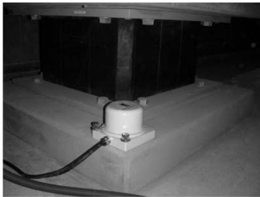
図 7. 基礎台の防水防滴型の検出器 （検出器後方：免震装置の角型積層ゴム）
