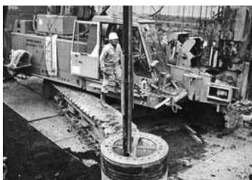
2005.3 保護管の溶接接続部の補強
