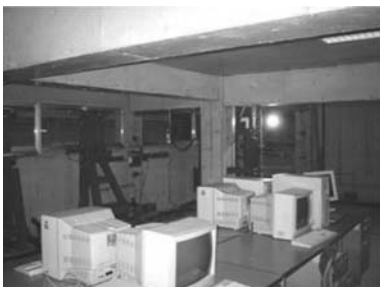
図 8. 1階事務室の状況
