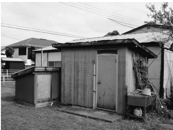
図 2. 宇佐美 24 号泉の現況。左側の小さな小屋に源泉の井戸がある。
