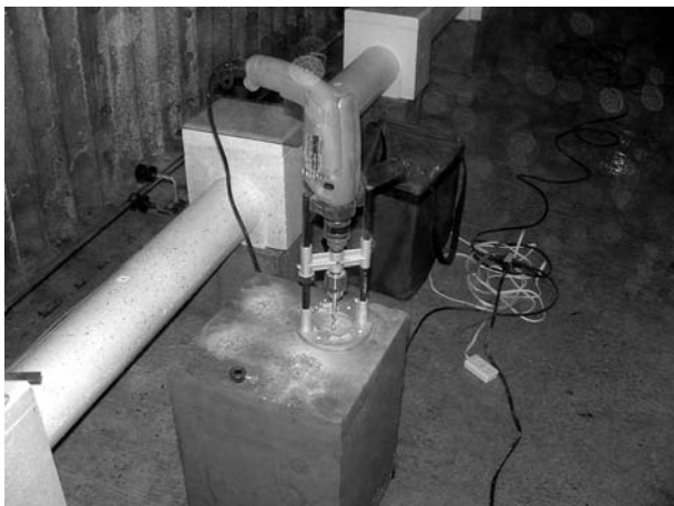
図 8. 中間検定台石に検定ステージ取付けのための穴開け
