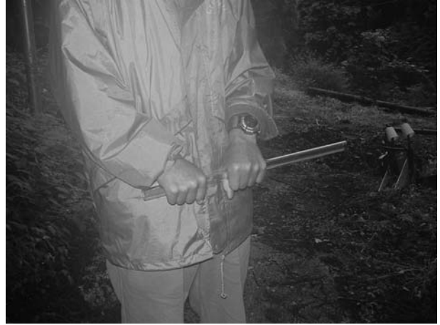
図 13. 連通管の切断作業
