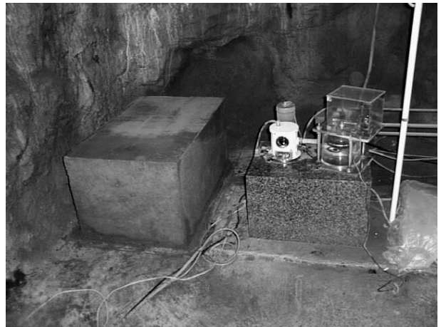
図 4. 既存の台石の脇に設置されたコンクリート台石
