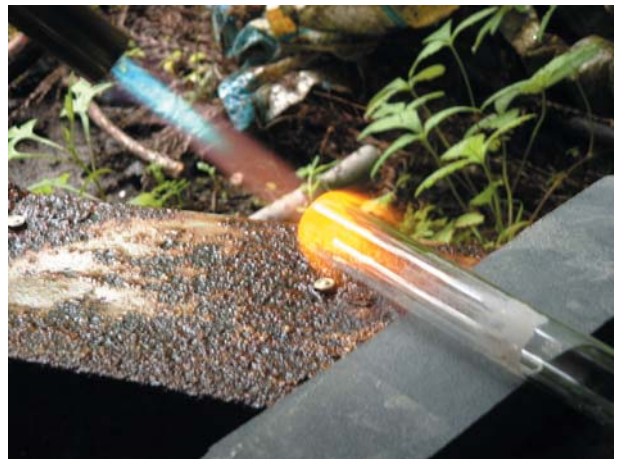
図 14. 連通管切断部分の溶解
