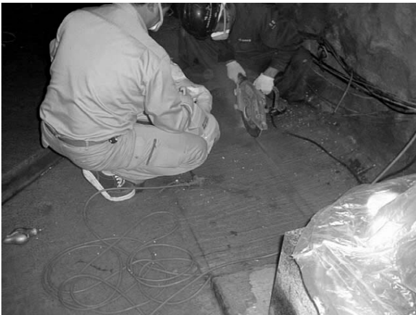
図 2. コンクリート床の縁切り作業
