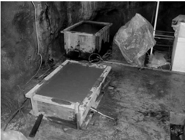
図 3. 型枠にコンクリートを流し込んだ後(手前がB端・奥がC端)
