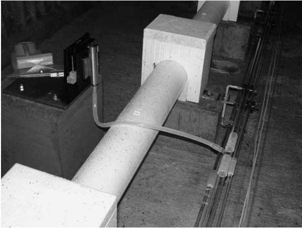
図 16. 中間検定ポットと連通管の接続
