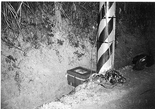
図 18. Station No. 34-Ch2 の設置点 アスファルトに孔を開けて設置された地震計.
