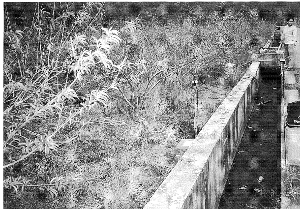
図 13. Station No. 13-Ch2 の設置点 中央部に GPS アンテナと梱包された DAT レコーダーが見える.
