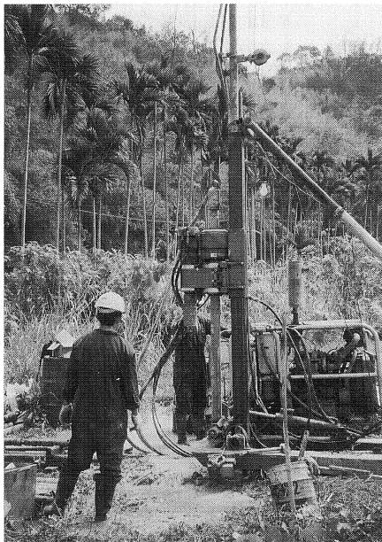
図 11. 発破点のボーリング作業
