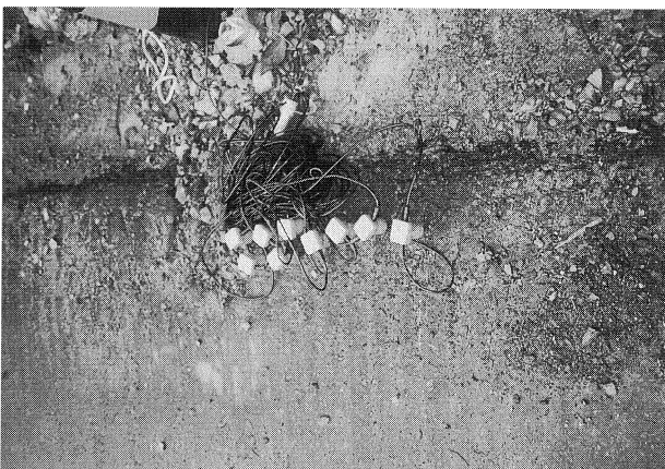
図 7. アスファルトに電動ドリルで孔を開けて設置された地震計
