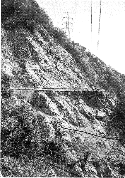
図 16. 岩山に作られた測線上の道路 右側が SP-E 方向
