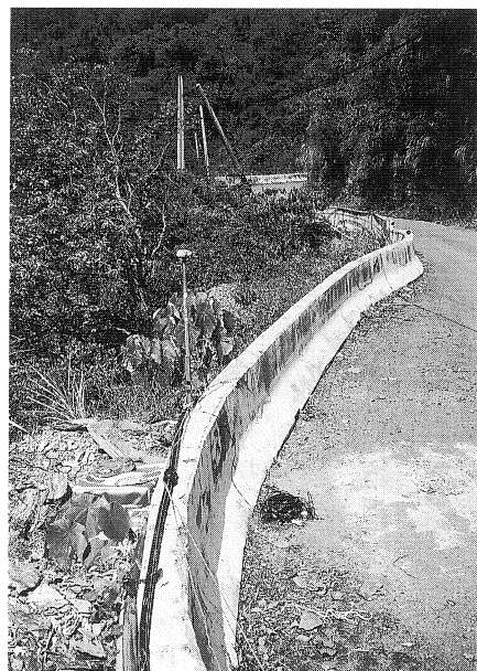
図 20. Station No. 53-Ch2 の設置点 アスファルトに孔を開けて設置された地震計. コンクリート 塀の左側は瓦礫の捨場で地震計の設置には向かない.
