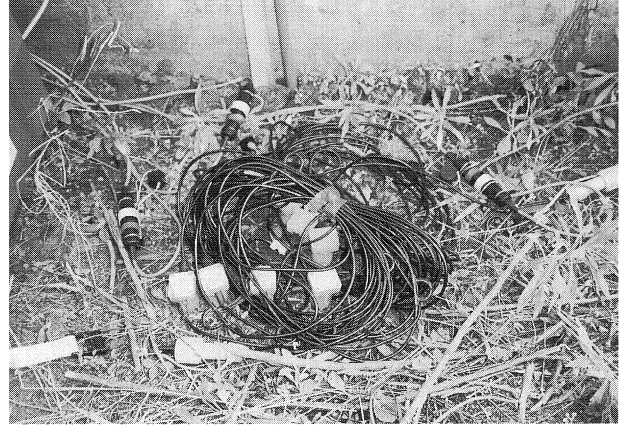
図 5. バンチングにより設置された地震計 S/N を良くする。9 個一組で 1 チャンネルずつ接続される。
