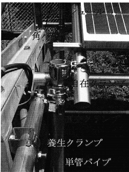
図 4. クランプの使用方法
