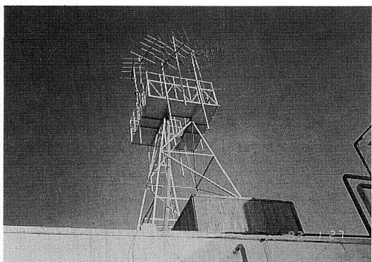
図 22. アスワンテレメータ観測網の受信アンテナ群。 150 MHz 帯 5 素子八木アンテナ。
