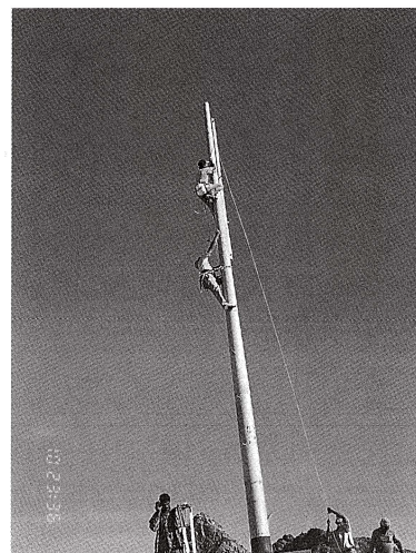
図 32. パンザマスト上部の組み立て。 角材に滑車をつけて各パンザマストのセグメントを吊り上げ、順番に下から積み上げていく。この方法は小人数（2 人程度）で建設する方法として日本で採用されている。
