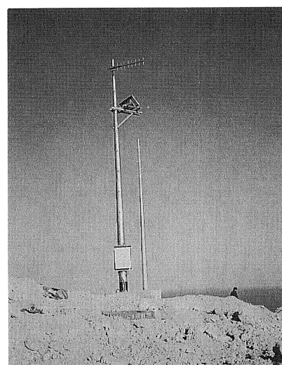
図 74. SHRM 観測点 (FM-FM 型上下動 1ch) と、後方のパンザマストの受信機で NABA 観測点を中継し、合わせて 2Ch で ABSH に送る。
