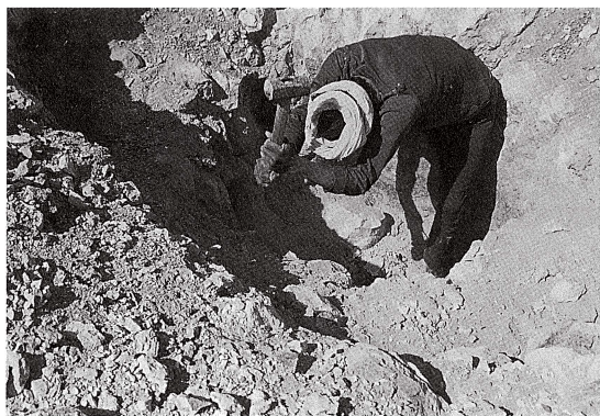
図 29. NRIAG 側スタッフがパンザマスト用の穴をノミとハンマーを使って掘る。 ほとんどの場所が岩盤のため、1 点あたり約 1 日を要した。
