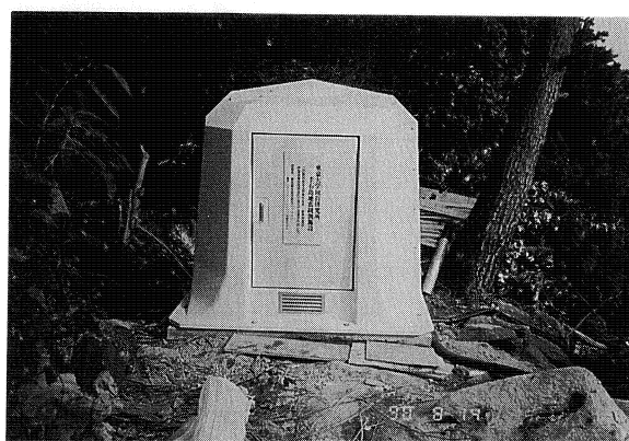
観測局舎の完成
