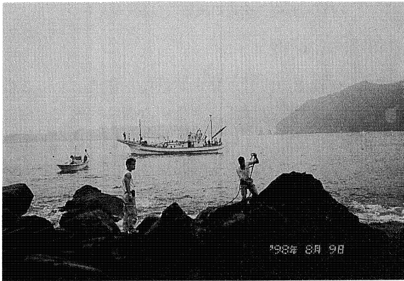
観測施設建設前に到着した大型漁船から工事現場前の岩礁地帯に資材搬入用ロープを渡す漁師さん
