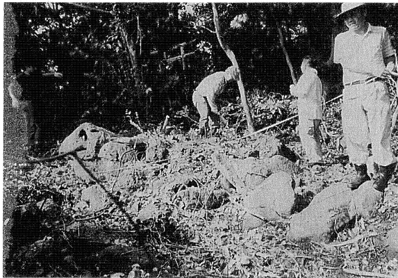
観測局舎・太陽電池設置位置の雑木、雑草等の除去
