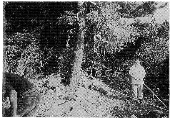
観測局舎・太陽電池基礎台の位置決め
