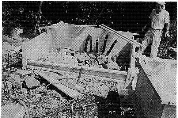
信号ケーブル引き込み用エフレス管 (黒色)
