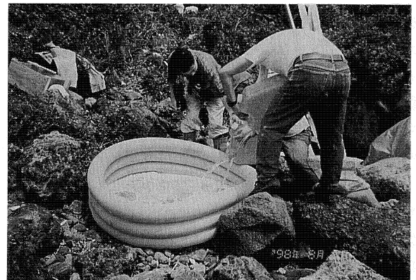
搬入されたコンクリート用の真水の貯蔵
