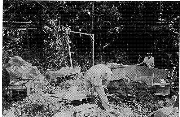
観測局舎基礎台の型枠製作
