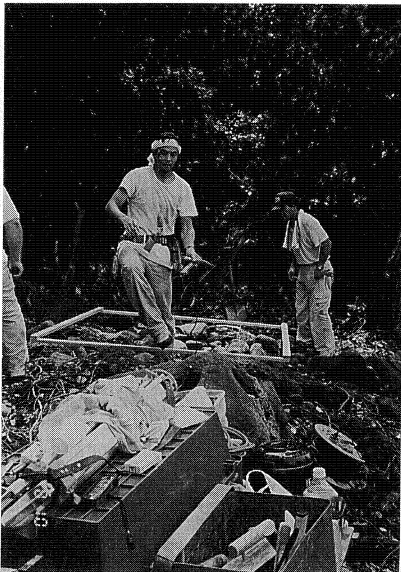
工事開始の観測局舎基礎台の位置決め
