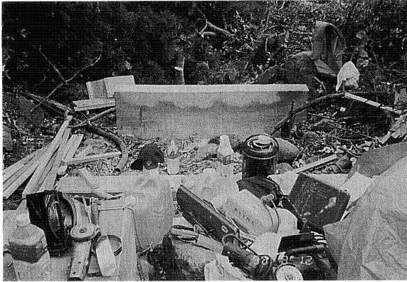
太陽電池架台支持基礎台の型枠解体
