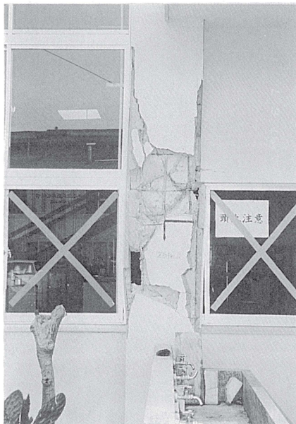
図 26. 南側柱入り口脇の柱，両脇の柱に垂れ壁・腰壁がつき，短柱化。
