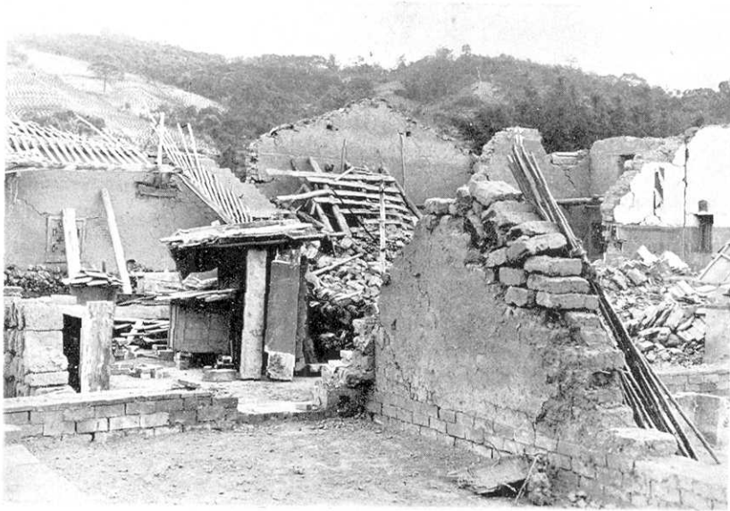
第 29 圖 峨眉庄藤坪の被害.
