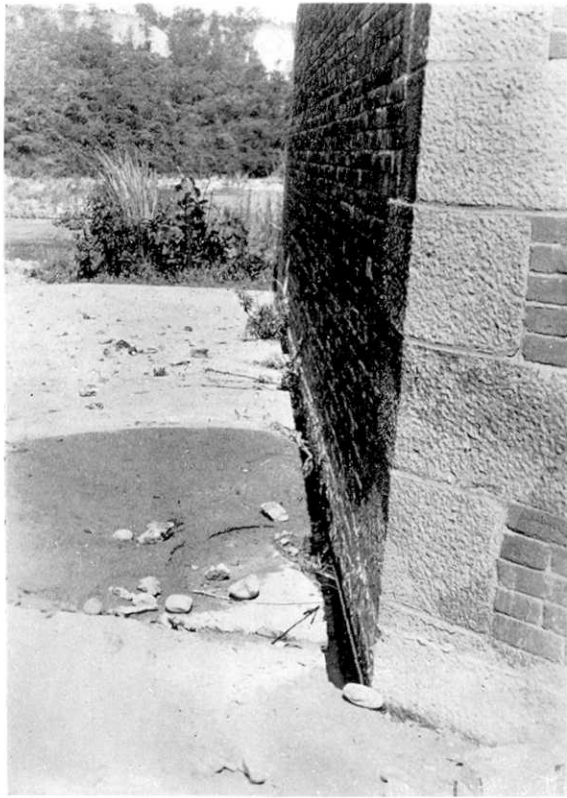
第151圖 内社川橋梁.
