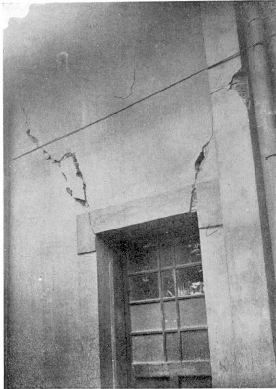
第 58 圖 後龍警察署コンクリート壁の亀裂. Fig. 58. Cracks in the concrete wall of the police station, Kōryū.
