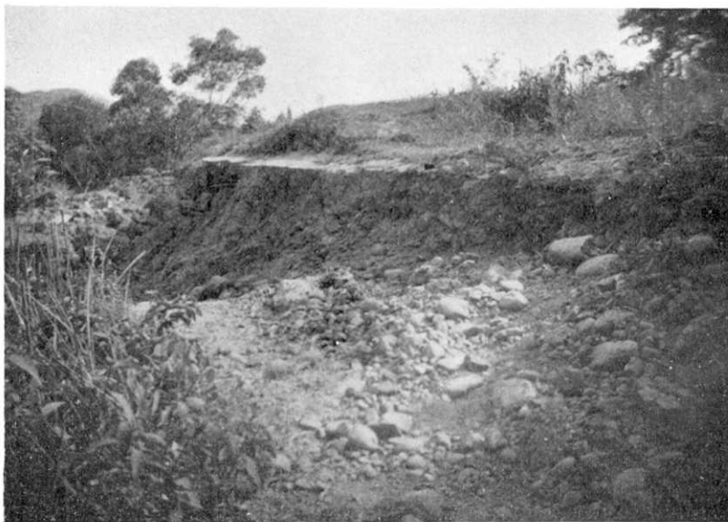
第105圖 公館庄棉子埔双合水間峠道の崩壊, 北側より南を望む。
