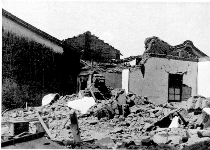
第 111 圖 公館庄公館. 土堆壁としては比較的良構造のもの. Fig. 111. Kōkan, Kōkan-syō. Walls built up of "Dokaku".
