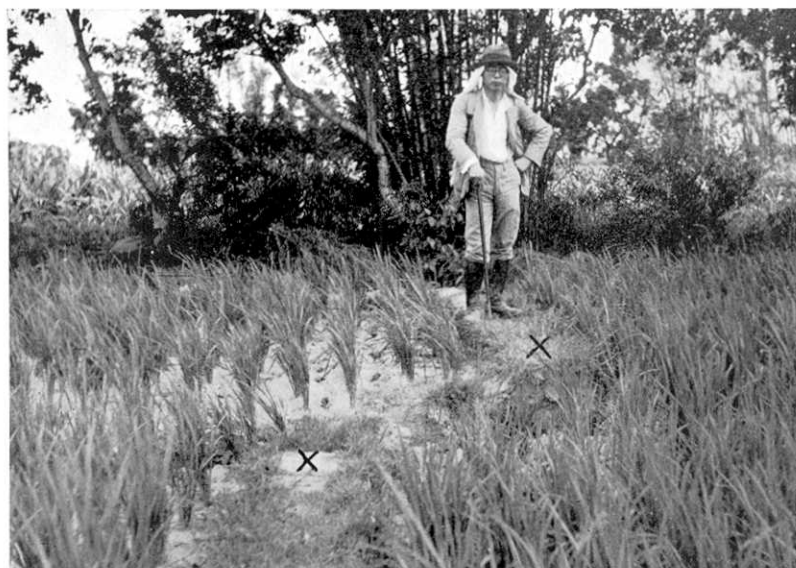
第219圖 内埔庄舊社字三角. 水田中を通る斷層. 走向 N72^{\circ}E , 北側45厘沈下し東方に120厘水平移動す. 斷層の北側より寫す.
