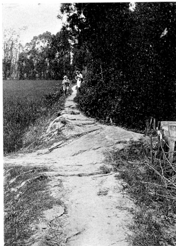
第213圖 内埔庄舊社. 斷層による埤圳堤防の破壊.
