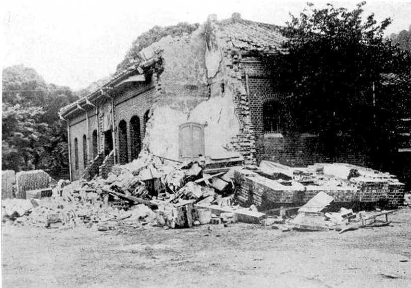
第 52 圖 南庄警察署の被害.
