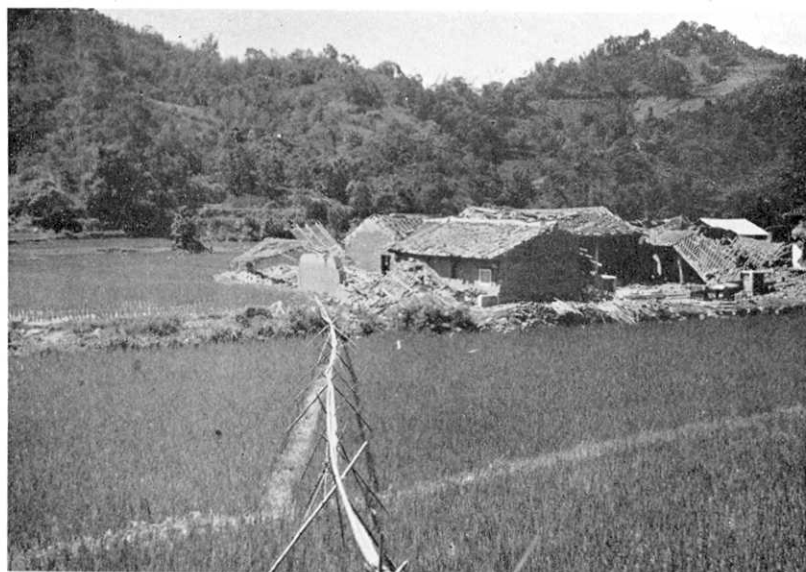
第104圖 公館庄棉子埔. 民家の破損. この附近水田の亀裂多數を生じたり.
