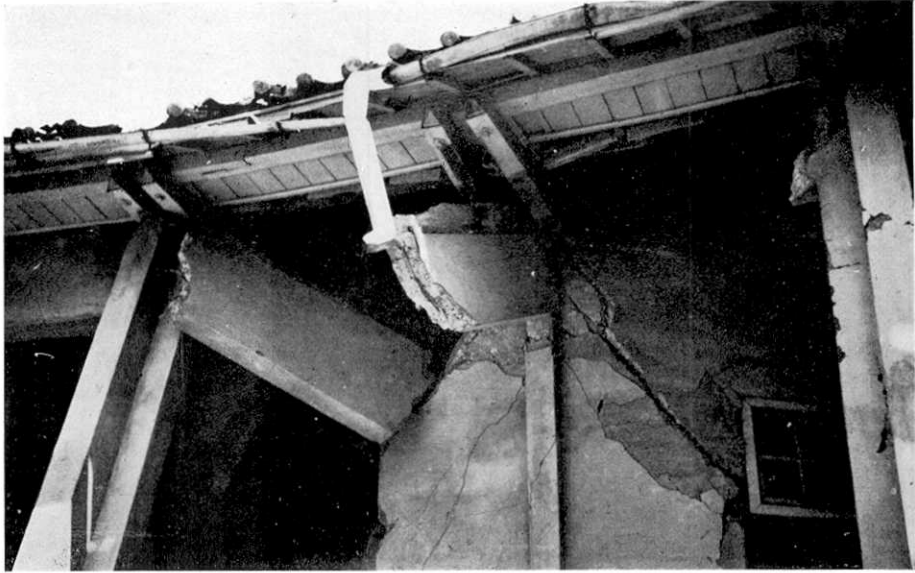
第195圖 鐵筋コンクリート造の被害 (屯子脚公學校).
