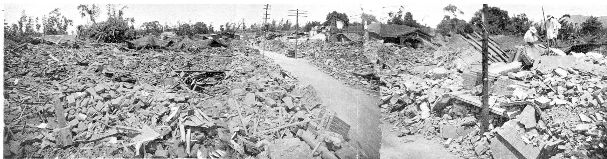
第 203 圖 内 埔 庄 屯 子 脚 の 被 害 状 況 (5 月 2 日 撮 影, 高 橋) Fig. 203. General view of Tonsikyau, Naiho-syô.
