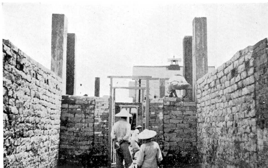
第250圖 臺灣建築構造の一例. 柱は鐵筋コンクリート壁は土塊積(東勢庄).
