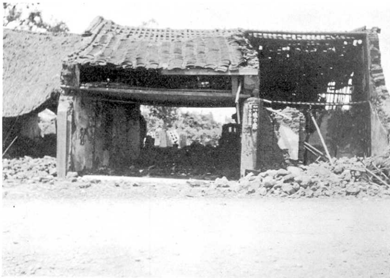
第180圖 内埔庄后里驛附近, 土埴家屋の屋根の構造が見られる.
