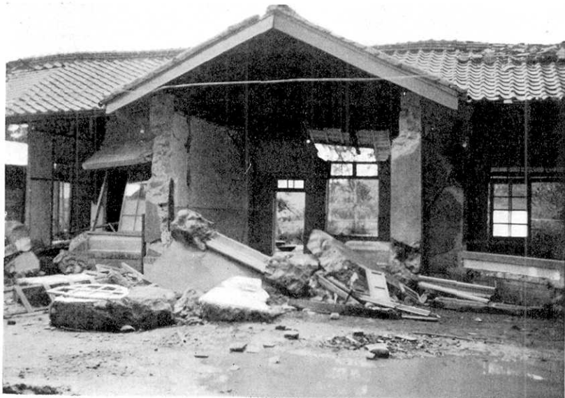
第 36 圖 コンクリート造巡査派出所の破損 (三灣庄大河底). Fig. 36. The destroyed police station constructed of concrete at Taikatei, Sanwan-syô.
