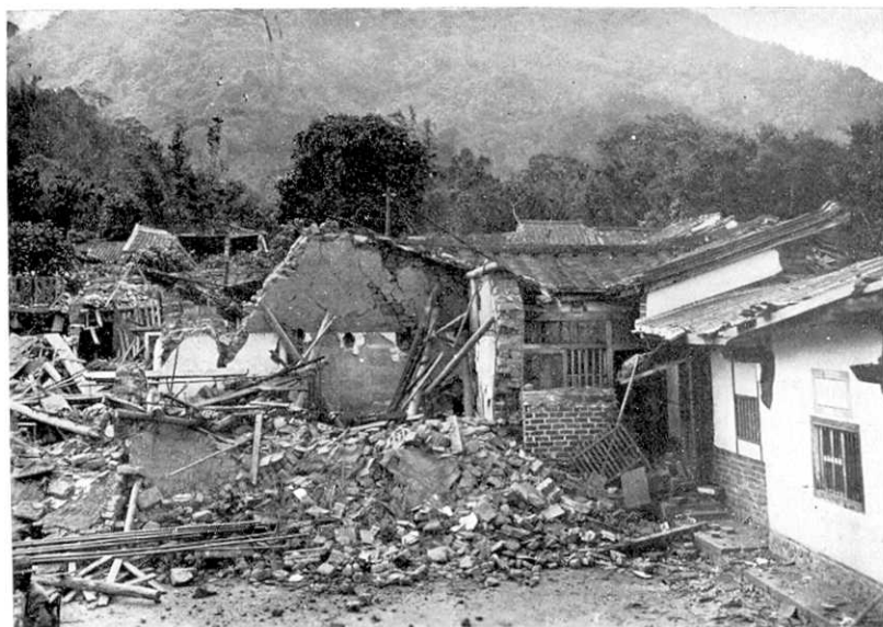
第 135 圖 大湖庄，竹高屋に於ける土塙家屋の被害。
