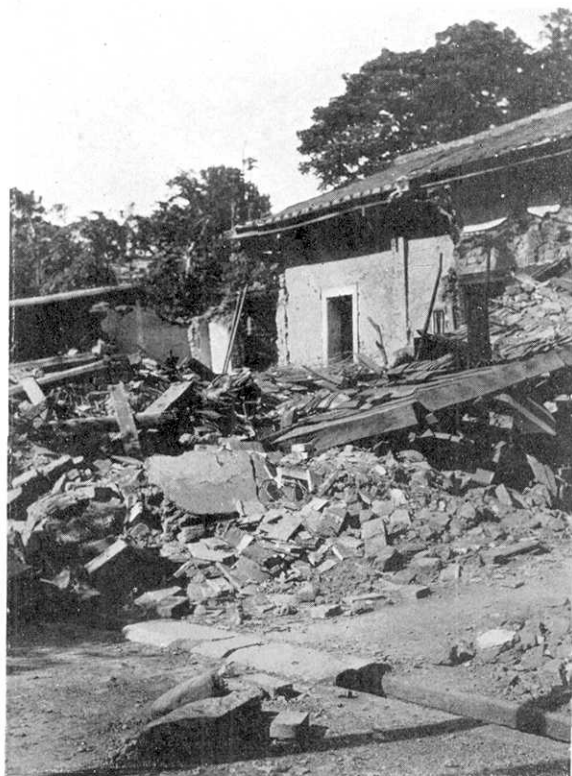
第 39 圖 大河底八股の廟. 中央部を残して兩翼は倒壊した. Fig. 39. Ruined "byō" (temple) at Hakko in Sanwan-syō.
