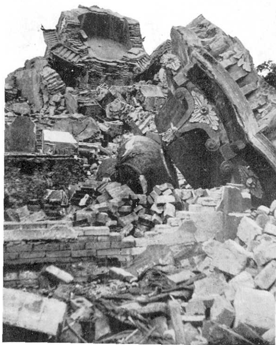
第 45 圖 獅頭山勸化堂納骨堂 (6 層の塔, 高さ 70 尺, 鐵筋入り煉瓦造) の轉倒.
