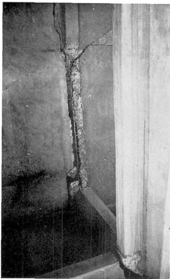
第204圖 鐵筋コンクリート造の被害 (屯子脚).
