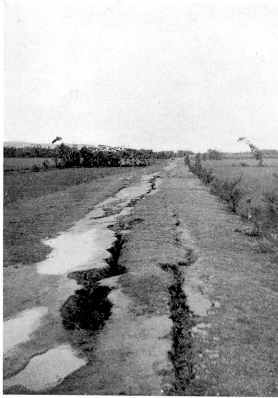
第59圖 後龍庄新港溪橋附近道路の亀裂.
