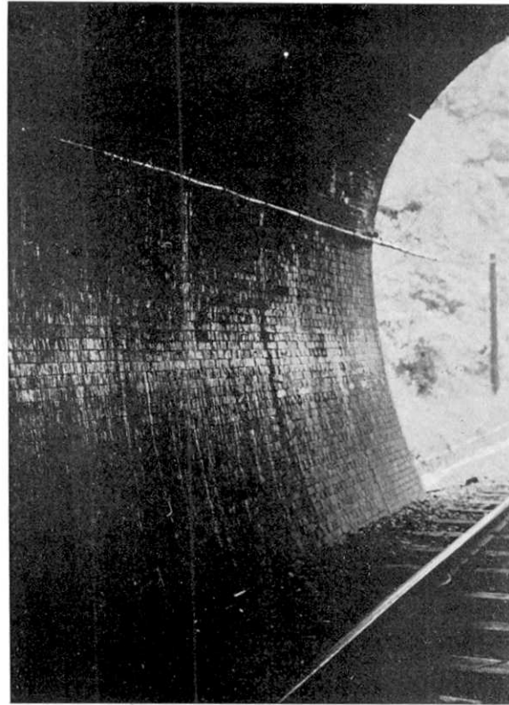
第143圖 第4號トンネル側壁の亀裂. この亀裂はトンネルを横切り, 亀裂の南側は北側に對して相對的に5 cm 西へ移動した.
