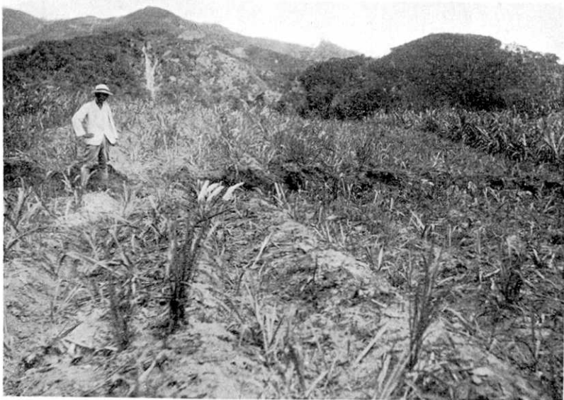
第72圖 公館庄枋屋家. 山腹に生じた地裂. 走向 N 10^{\circ} E . 山腹側約 30 厘沈下を示す. これより若干低き所にも地裂を生じたり. 延長は 200~300 米程度.
