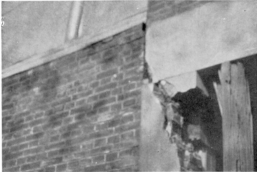
第259圖 亭仔脚梁の支持不充分なるもの、被害、昭和5年12月臺南州下強震によるもの(新營にて寫す).
