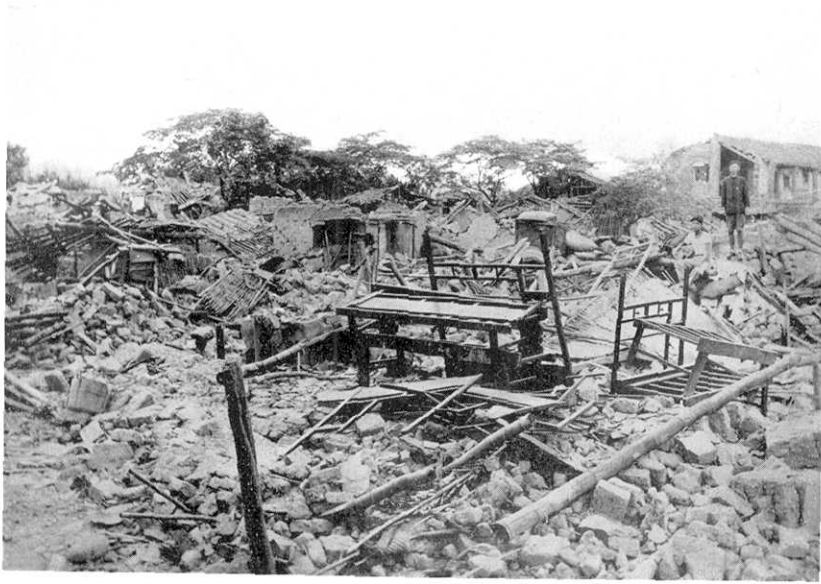
第 47 圖 南庄大南埔の被害.
