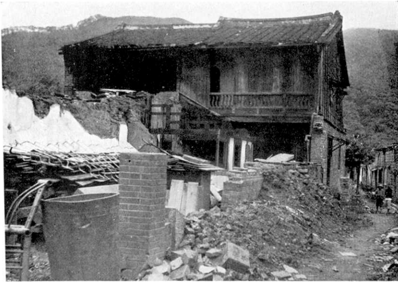
第 51 圖 南庄. 木造式家屋は倒潰せざりしもその前方の土塙家屋は潰れたり.
