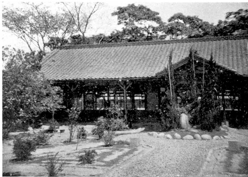
第 233 圖 神岡庄神岡の公學校. 木造にて被害僅少. Fig. 233. The Kamioka primary school of wooden structure, Kamioka, Kamioko-syô.
