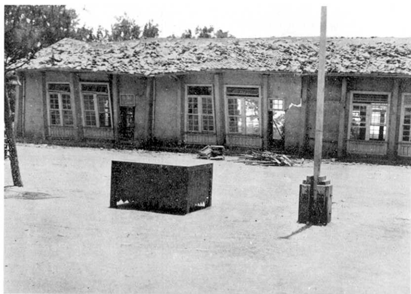
第192圖 内埔庄. 内埔公學校鐵筋コンクリート校舎の被害.
