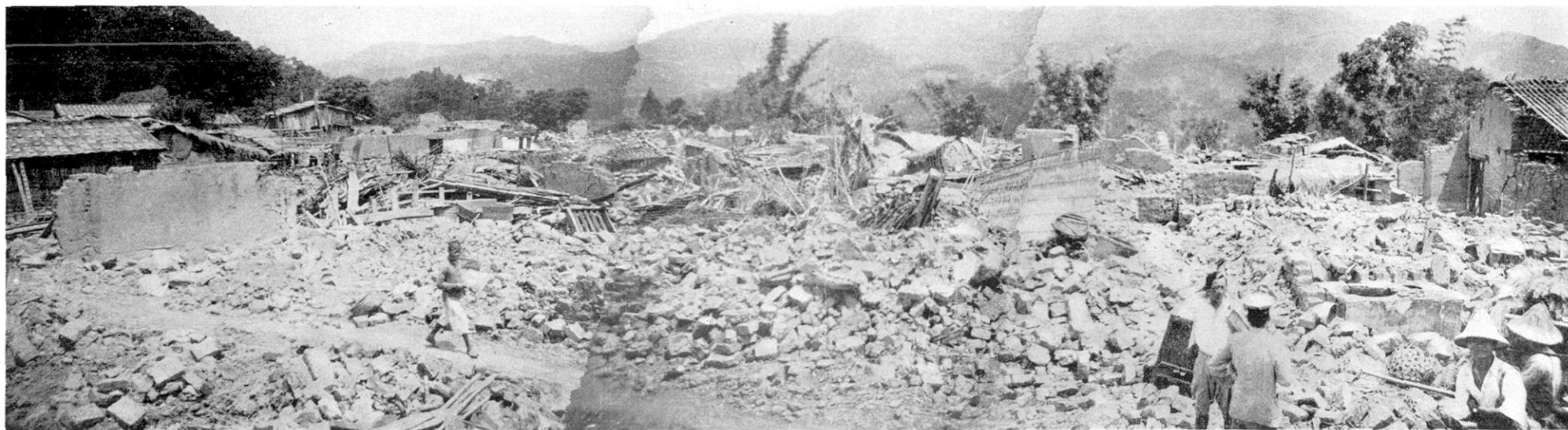
第 26 圖 峨眉庄峨眉の慘狀. Fig. 26. The ruin at Gabi, Gabi-syô.
