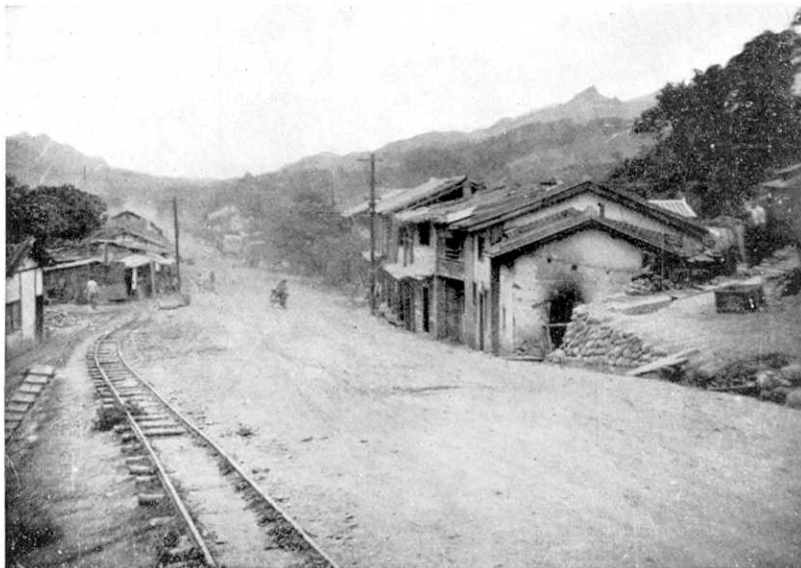
(5月11日撮影, 高橋) 第130圖 大湖庄大湖の北端, 土埴造も餘り被害を受けてゐない. Fig. 130. The north end of Taiko, Taiko-syō.
