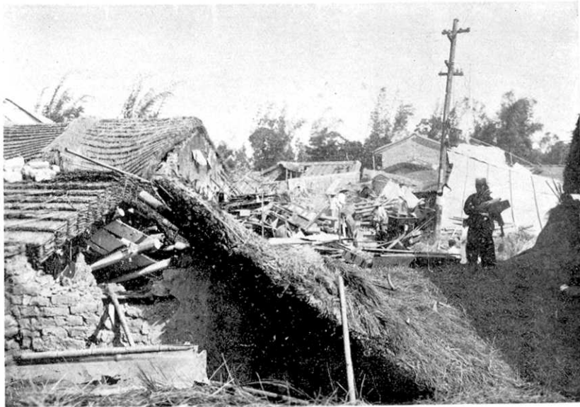
第 232 圖 神岡庄神岡. 倒潰家屋の屋根を踏んで交通してゐる. Fig. 232. Kamioka, Kamioko-syô.
