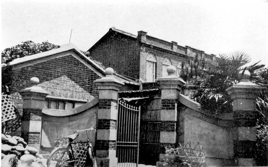
第207圖 施工よき煉瓦造民家(内埔庄)被害なし.
