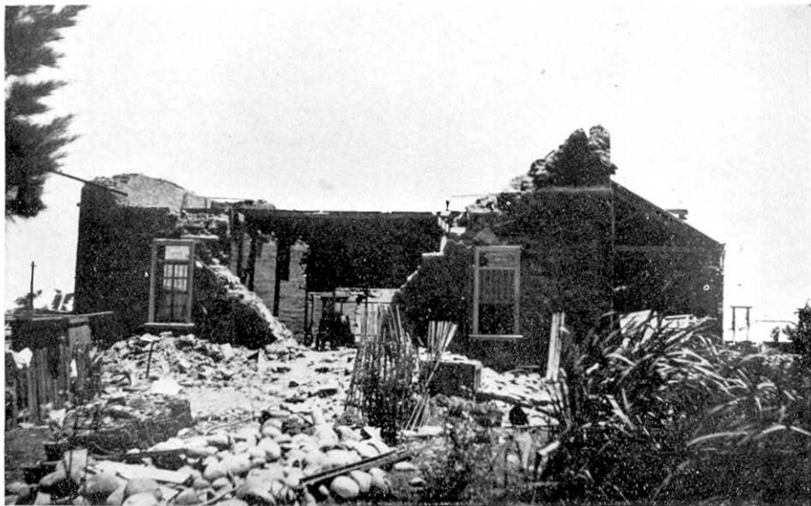
第243圖 二階建土塊造の被害(清水街).
