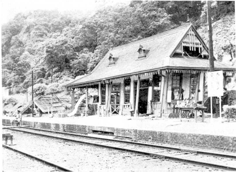
第 163 圖 内埔庄. 大安驛舎, 西南方に大傾斜し危険のため取毀さる. Fig. 163. Naiho-syô, Wooden building of the Taian railway station.
