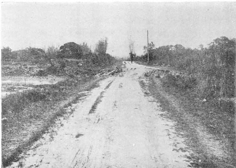
第23圖 梅仔坑地震斷層。(1914年發行臺北測候所英文報告より) The Baisiko earthquake fault near Bisyo, Kagi prefecture, Taiwan. (From SE).
