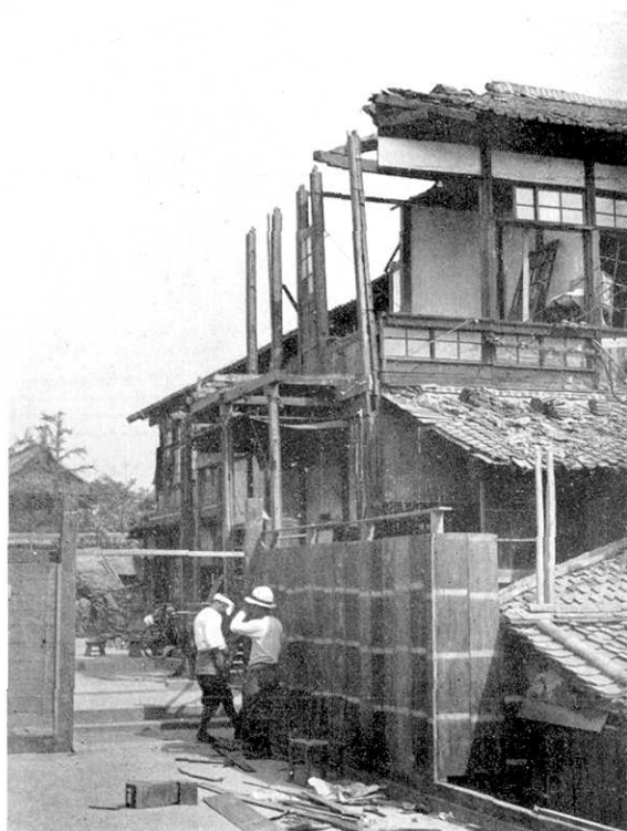
第 4 圖 天王寺第一小學校の被害の一部 柱上部枘の完全に残されたるに注意
