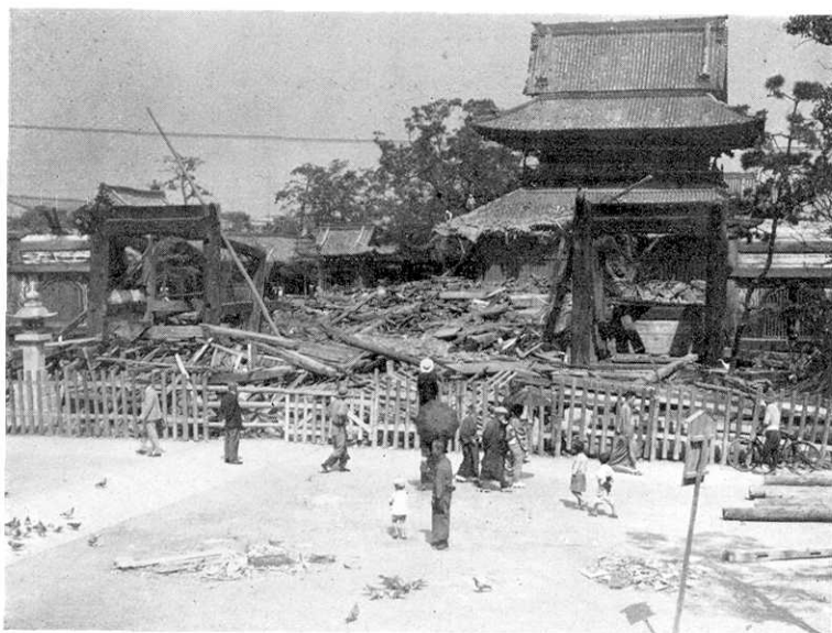
第 3 圖 倒潰せる天王寺建物 仁王門及び廻廊下部の残存せるに注意
