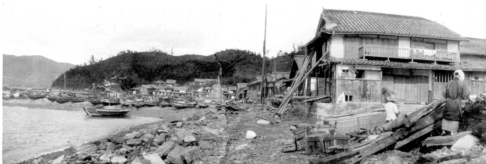
第 48 圖 兵庫縣三原郡沼島村 淡路島の東端より約 2 km 離れた島である。(第 47 圖の地圖参照) 流失家屋はないが倒潰家屋 30 個を出し、行衛不明者 7 人を出してゐる。兵庫縣下では 1 番津浪が猛威を振つた所である。(106 頁沼島の項参照) 寫眞中右手の A 附近で家屋内の浸水跡より上昇量は 2.6 m となる。
