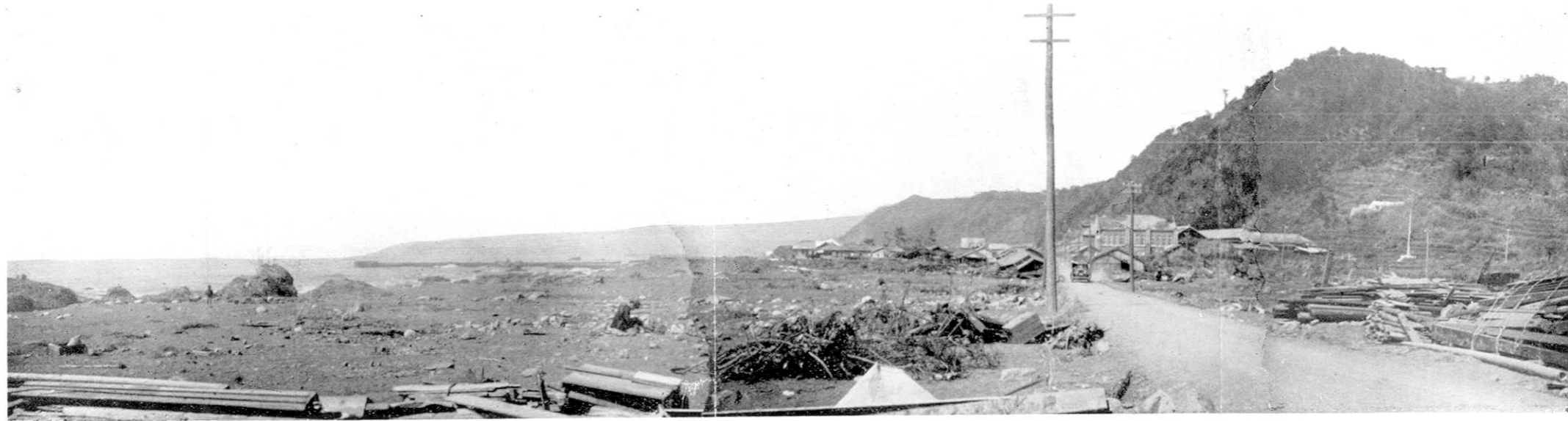
第 65 圖 高知縣安藝郡室戸崎町津呂東入口，この附近道路は海面上 6.5 m あり，道路の兩側にあつた人家 4 軒全く流されて跡形もなし。津浪直後は道路上は砂礫が海水の爲め埋まり，全く荒涼たるものであつた。寫真に見える電柱は新に設けたものなり。
