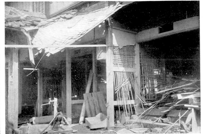
第 8 圖 大阪府堺市湊海岸 第 2 圖 D 附近、溢れ流れる海水の爲め海岸近くの家は屋内を洗ひ去られ非常な被害を受けてゐる。この附近での津浪上昇量は 4.0 米
