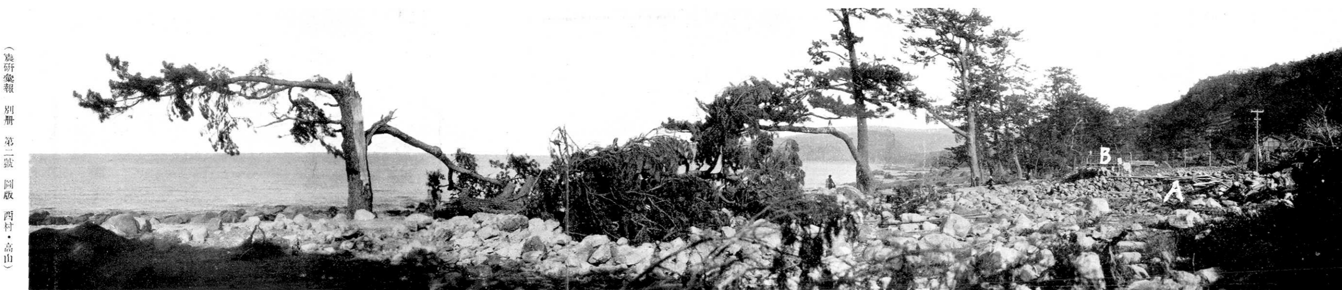
第 72 圖 高知縣安藝郡室戸町平尾 この附近では人家3軒流失す。人道は海面より6~7m位の高所にあるが津浪はこれを感じ A 附近にあつた人家は1家7人中5人の流死者を出してゐる。Bの納屋も流された跡に建てつつあるものであるが B 附近では浪先は道路上2.5mに及び津浪上昇量は8.2m以上あり、田畑に石垣の崩れ込んでいるのが見られる。松の折れてゐるのは風力の強かつた事を思はしむ。
