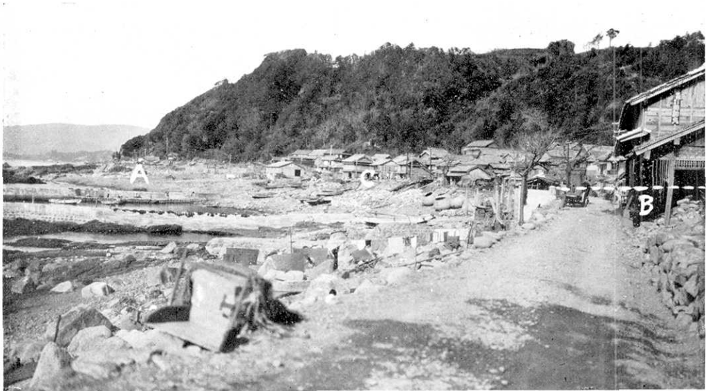
第 76 圖 高知縣安藝郡奈半利町加領郷 90 軒位の人家ありしが C 及び A 附近で 27 軒流失倒潰す、死者はない。A 附近の惨況特に言語に絶す、B 附近の侵入跡より津浪上昇量は 5.5~6.0 m となる。
