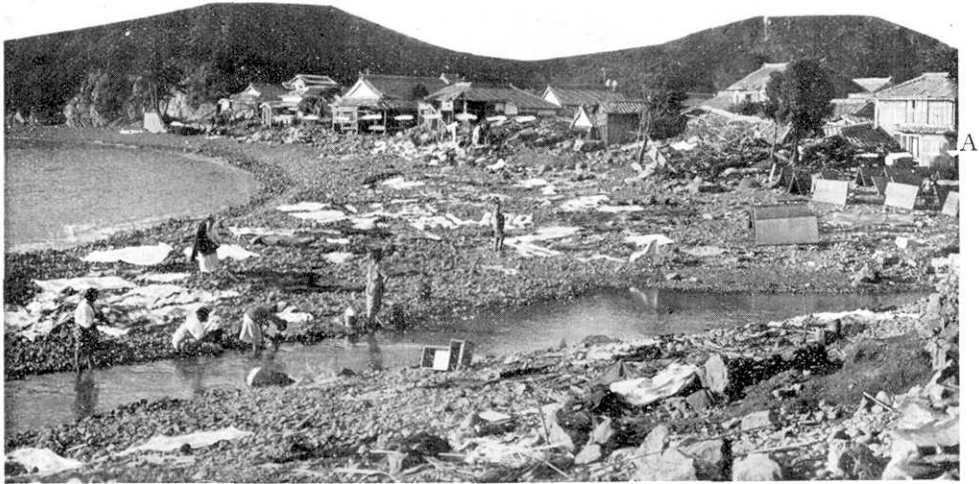
第 15 圖 和歌山縣海草郡加太町深山 8 軒人家流され 5 軒倒壊されてある。寫眞 A での人家内よりの浸水より 1.7 m と上昇量はなる。B 附近の人家のある所は深山では 1 等の高所であるが人家の倒壊されたものあり、この所で上昇量は 3.1 m となる。(第 14 圖及び 87 頁の説明参照, 9 月 21 日加太町雜崎氏撮影) (昭和 9 年 9 月 24 日由良要塞司令部檢閲済)
