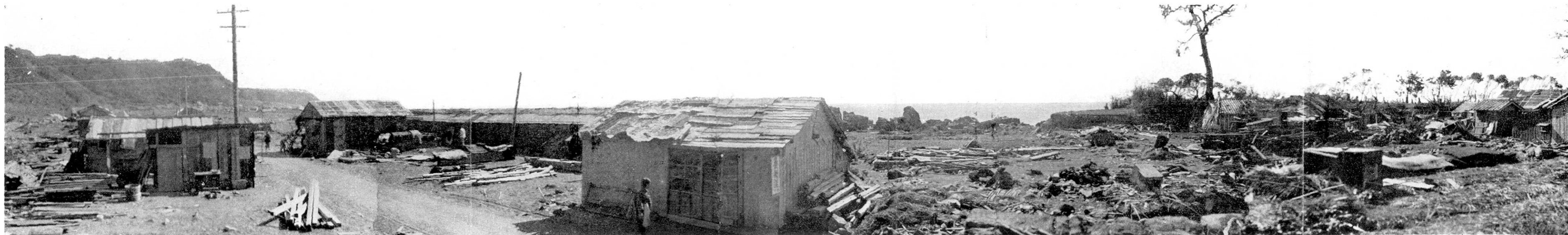
第 69 圖 高知縣安藝郡室戸岬町耳崎 急激な海水の溢流によつて全部落全滅に近い。即ち45軒の人家を流失或は全潰し、6~7軒の半潰を出したのは言語に絶する被害である。しかし1人の死者も出さなかつた事は幸であつた。写真に見えるは急造のバラックである。
