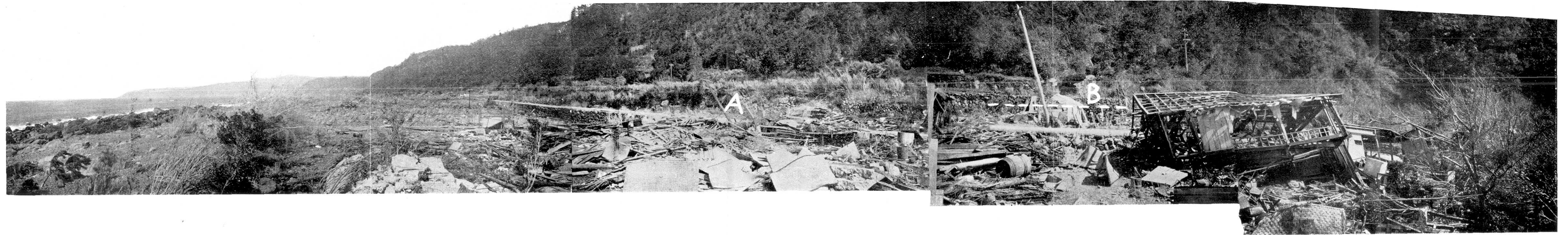
第 64 圖 高知縣安藝郡室戸崎町坂本 A 附近では 4 軒の人家全部流され 5 人の死者を出し B 点での点線は津浪上昇線を示す、上昇量 8.5 m.
