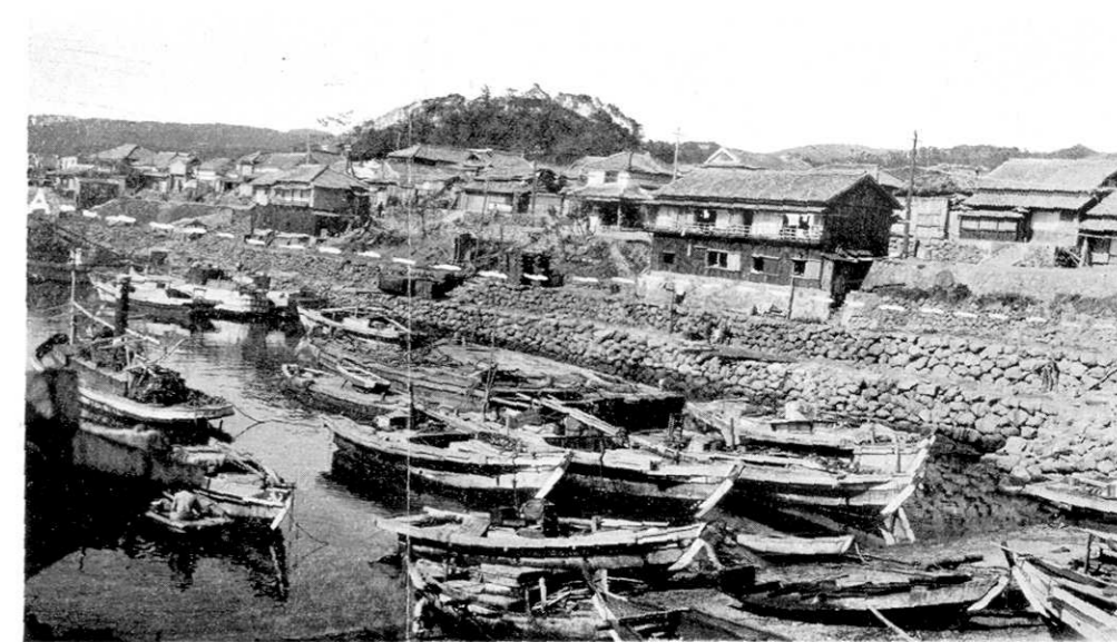
第 71 圖 高知縣安藝郡室戸町室津港 第70圖で見る様な長方形の港である。點線で津浪上昇量を示す。A附近には検潮所があつたが流されたのは残念。この所で上昇量4.6mあり、港内海水の動搖の爲め舟の衝突等の爲め沈没せるものあり。
