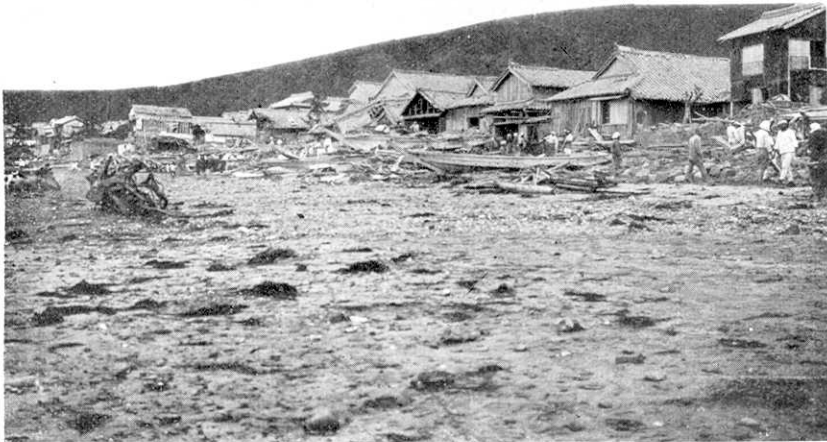
第 16 圖 和歌山縣海草郡加太町 (88 頁参照) 津浪上昇量は人家の浸水跡より 1.8 m となる。(9 月 21 日加太町雜崎氏撮影) (昭和 9 年 9 月 24 日由良要塞司令部檢閲済)
