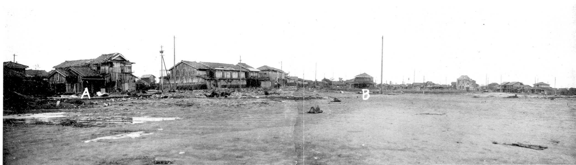
第 3 圖 大阪府堺市三寶町 海面と同じ位の低地であるが堤防決潰の爲め海水は洪水の如く流れ込み非常な被害を受けた。A では 1 軒流失してゐる (本文 81 頁の説明参照)。
