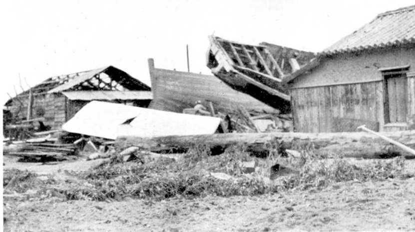
第 33 圖 淡路島福良町字向谷の被害状況 (10月2日撮) 由良要塞司令部検閲済
