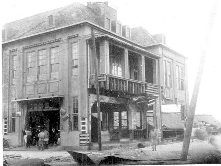
第 13 圖 風浪の爲前面を大破せられたる税関看視所。大阪築港大棧橋根元
