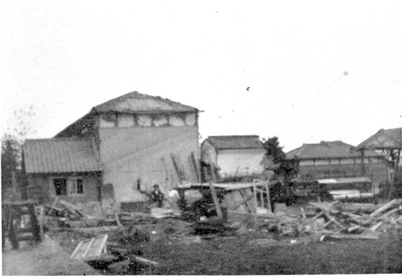
第 39 圖 堺市三寶濱南島附近 (9 月 29 日撮) Fig. 39. Damage at the Minamisima, Sakai.
