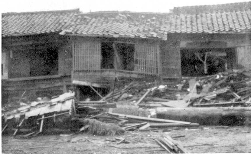
第 16 圖 大阪市鶴町海岸の家屋の破損、二階建一階建となる（9月30日撮）。
