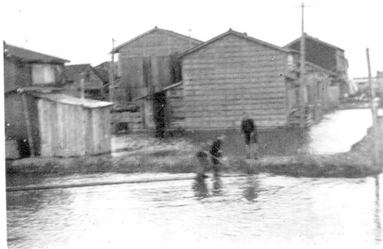
第 7 圖 満潮時の浸水 (深川区汐崎町, 昭和 9 年 11 月 8 日午後 4 時 20 分撮影) Fig. 7. Inundation at the time of high water.
