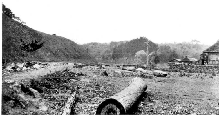
第 367 圖 歌津村港. 海岸より奥へ向つて撮す. 津浪は狭い谷に沿つて約 600 米浸水し 10 數戸流失せり. 浪高海岸にて 3.5 米. (5 月 19 日 高橋撮影)
