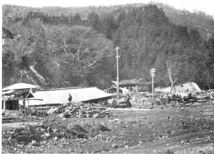
第 281 圖 釜石町嬉石。土臺石より7,8尺移動した所で40~50度廻轉して倒潰した家(矢印)。(3月6日高橋撮影)
