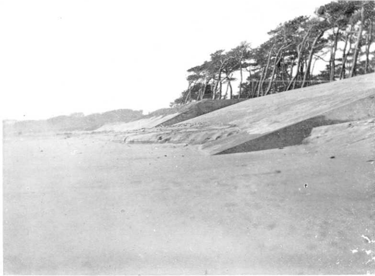
第 418 圖 福島縣, 前谷地附近海岸のコンクリート堤防. 砂及び漂流物が打上げられてゐる. (3 月 30 日宮部撮影)
