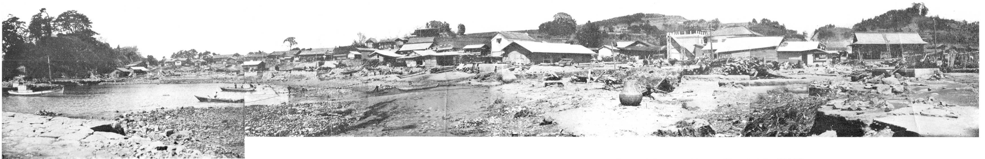
第 339 圖 廣田村泊. 寫真右寄りの海岸に流失家屋數軒あり. 右につゞく田圃には大分奥まで浸したるも部落内は海岸より 200 m 程浸水したるのみ. 但し部落は少しく傾斜地にあり. 浪高は 7.0~8.5 m. (4 月 8 日高橋撮影)
