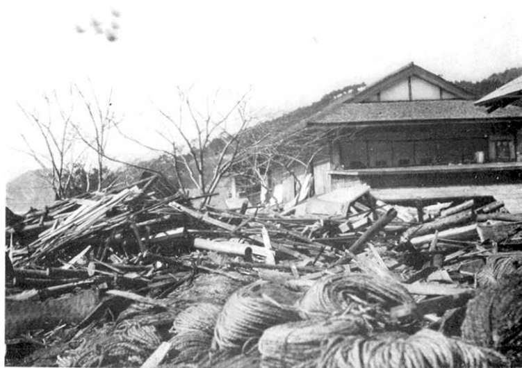
第 279 圖 釜石町製材所附近。漂流物山積せる爲か破損をまぬかれた家。(3月7日高橋撮影)
