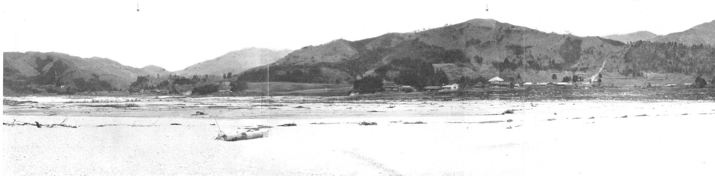
第 296 圖 吉濱村本郷。写真は海岸より西方を望みて撮す。部落は道路に沿ひやゝ高所にある爲浪高大なるにも不關殆んど被害なく、たゞ田圃は一面の砂原となる。海岸にありし堤防決潰して田圃中所々に残骸を止めたり。津浪は役場前(右手矢印の下)の道路に乗る。浪高此處にて 14 m 海岸にて 16 m あり。谷奥の小屋(左手の矢印下海岸よりの距離 950 m)裏手の竹藪まで浸入す。小屋は浸水地上: 40 cm。(4 月 10 日 高橋撮影)
