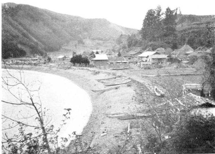
第 384 圖 十三濱村相川 寫眞中央部矢印にて示せる 2 階家にては階下天井まで浸水せり。津浪は向側山裾の谷に添ひて 500 米程浸入せり浪高 5.5 米。(5 月 21 日 高橋撮影)
