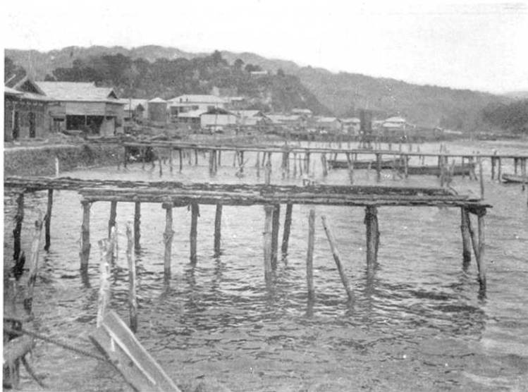
第 265 圖 山田町. 棧橋の板が流失し桁のみ残れるを示す. (木村撮影)
