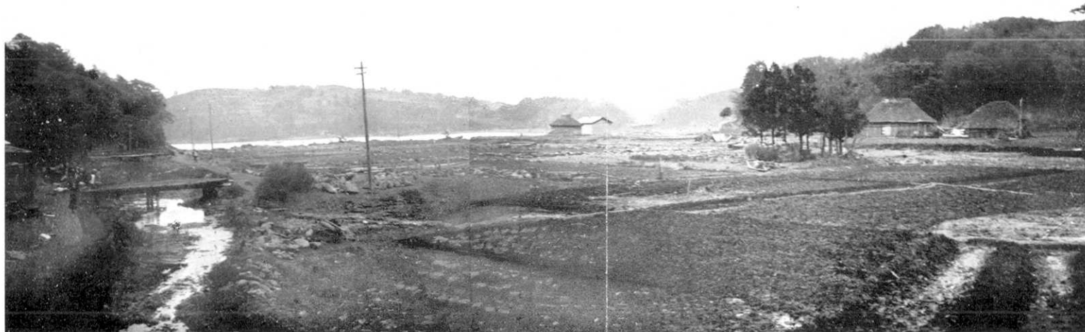
第 368 圖 歌津村田ノ浦. 部落の中央より海岸を望む. 海岸にありし納屋, 住宅流失せり. 但し部落の主要部は北側山裾に偏してゐて地盤 やゝ高き爲被害割合に少し. 浪高は約 5 m. 田圃は一面石原となる. (5 月 19 日 高橋撮影)
