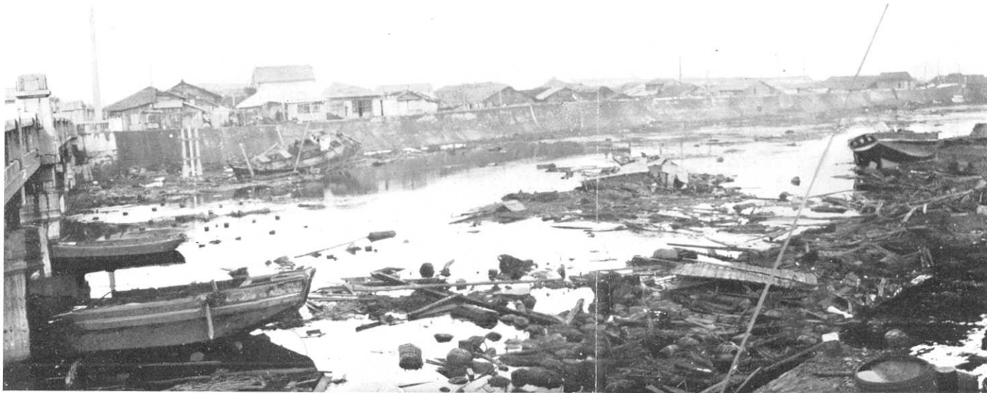
第 282 圖 釜石町大渡橋畔。海岸より 1 軒以上も隔りたる所に架してある大渡橋附近。嬉石、松原方面より押流されて来た船、家具、柱、屋根等の河中に充滿してゐる光景。小舟は此橋の上流 300 米邊まで流されてゐた。津浪は河岸を溢れなかつた。(3 月 5 日高橋撮影)
