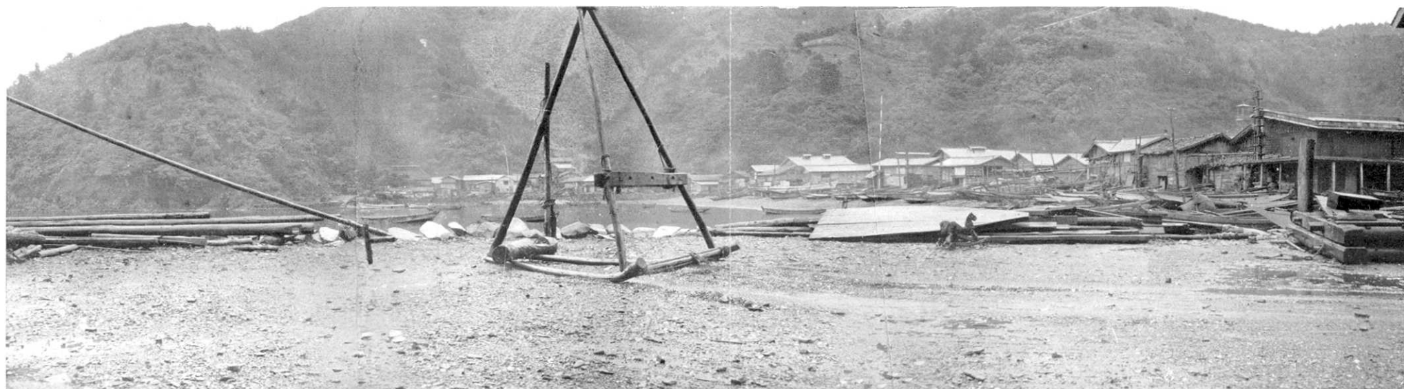
第 386 圖 十五濱村船越。海岸の家は皆地上 2 m。近く浸水したれども倒潰せるもの少なし。家大概大きく頑丈に作りある爲か。浪高は写真手前側にて 3.7 m 向側山際にて 4.0 m 程なり漂流物の運動より考ふるに向側山裾に海中に突出して防波堤ある爲水は写真手前より先の方へと灣内にて廻轉して流れたらしいと言ふ。（5 月 22 日 高橋撮影）
