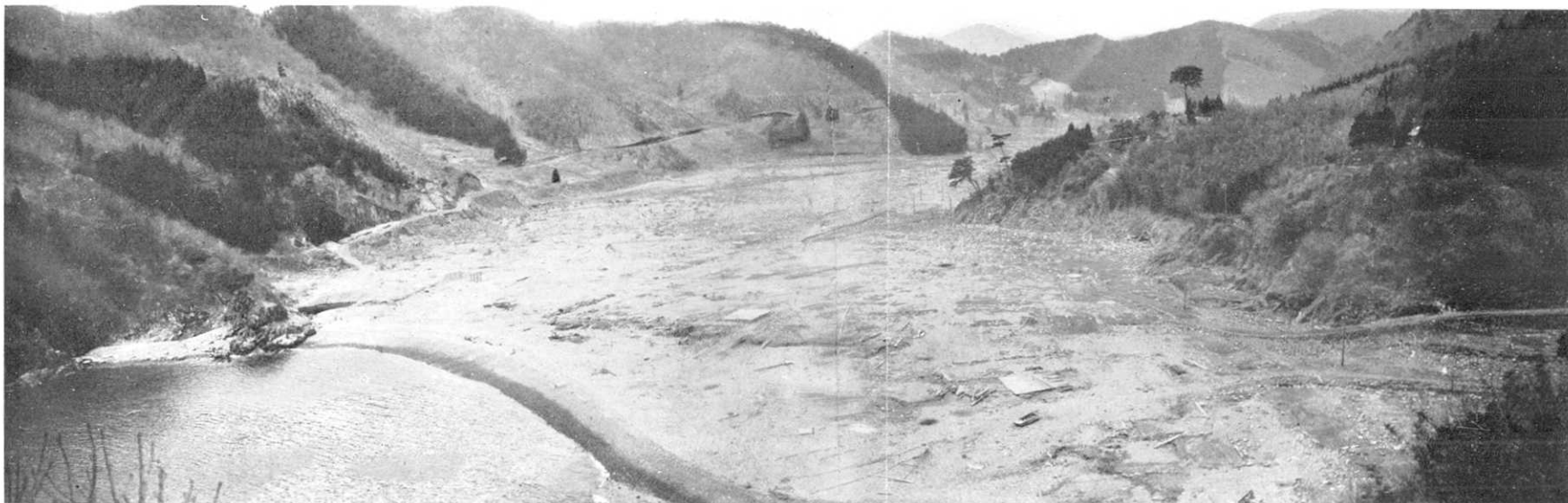
第 288 圖 本郷（唐丹）部落は文字通りの全滅で全く荒野と化した。（4 月 30 日 石本撮影） Fig. 288. Panoramic view of Hongô (Tôni). Village completely demolished. (Photo by M. Ishimoto, April 30.)
