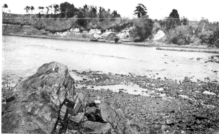
第 360 圖 氣仙沼大島要害. 附近の海成粘土層と段丘. この附近の津浪の高さは約 1.5-2 m. 内外であつた. (5 月 5 日 大塚撮影) Fig. 360. Sea cliff of Yoogai, Kesennuma Oosima. Marine terrace and its forming Diluvial deposits. Height of tsunami water amounts about 1.5-2 m. (Photo by Y. Otuka, May 5.)
