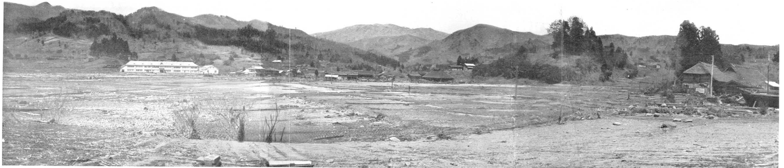
第 298 圖 越喜來村浦濱。部落東端より西北に向つて撮す。寫眞の左は海につゞく。部落内殆んど皆浸水し中央川筋(矢印の下)に沿ひては特に流失家屋多し。學校は床上 2 尺程浸水し土砂著しく沈積せり。學校右手の 2 階屋も大破したり。學校前の田圃は大半砂原となり砂の厚さ 1 尺に及ぶ所あり。田圃中にありし記念石碑 38 間押流さる。(4 月 11 日 高橋撮影)
