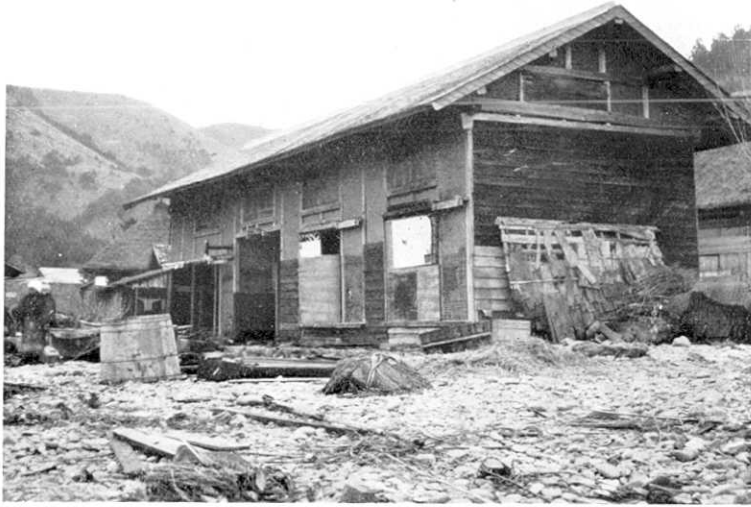
第 399 圖 女川町石濱。土壁の津浪に洗はれた所は土落ちて小前だけとなる。津浪の高さを示す。(3月4日 高橋撮影)
