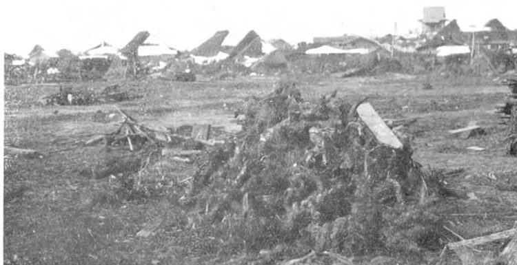
第 226 圖 三澤村四川目. 低地にありし納屋及住宅は殆んど皆流失したる状況, 寫眞に見ゆる家は何れも高さ 海抜 5 米の高臺にあるもの. (3 月 11 日高橋撮影)
