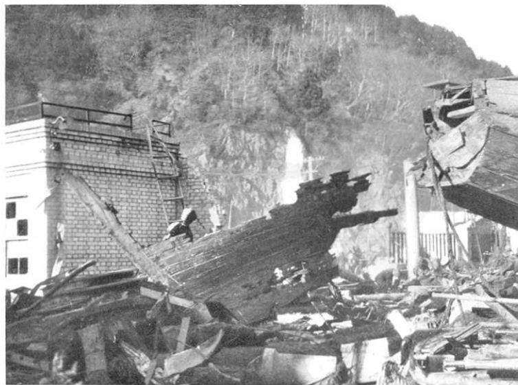
第 274 圖 釜石町場所前。陸上に打上げられし漁船が津浪直後に起りたる火事の爲焼失せるものを示す。(3 月 6 日高橋撮影)
