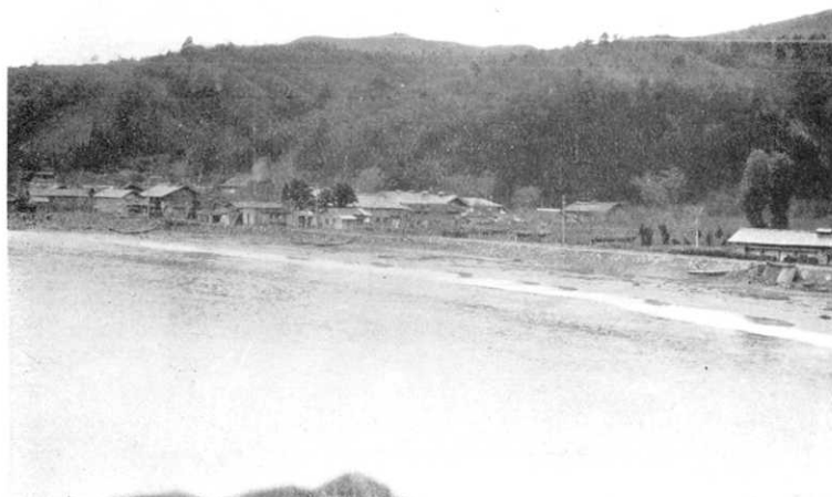
第 387 圖 十三濱村白濱。浪高 3 米餘なりしも護岸の爲浸水せず。(5 月 21 日 高橋撮影)
