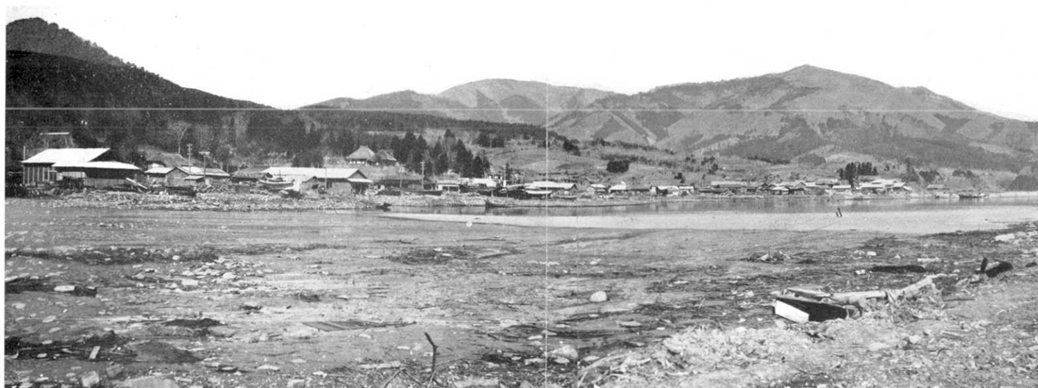
第 331 末崎村細浦。部落内の家屋は殆んど皆浸水し、海岸線のもの流したるもの可成りあり。當所は交通至便の爲回復早く、写真のトタン屋根のものは殆んど皆津浪後に建てたる假家なり。浪高 4 m ~ 6 m。當所は地形複雑なためか部落内の津浪の水の運動甚複雑にして浪高も所により大差あり。(4 月 14 日高橋撮影)
