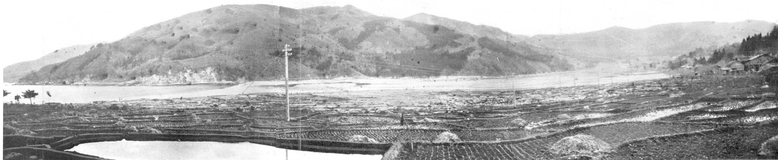
第 297 圖 本郷(吉濱)。明治 29 年の津浪後部落は写真右手の高地に移された。此の爲め今回の津浪は低地を前回の場合と同様に襲つたにも關らず家屋の災害は免れることが出来た。(4 月 29 日 石本撮影)
