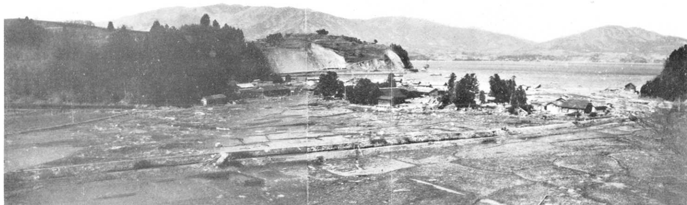
第 341 圖 長部。低地が奥の方迄続いて居り、家屋、船舶の破片が到る所に散在するのが見られる。浪高比較的低く少しく土臺の高い家屋は災害を免れて居る。(4月27日 萩原撮影)
