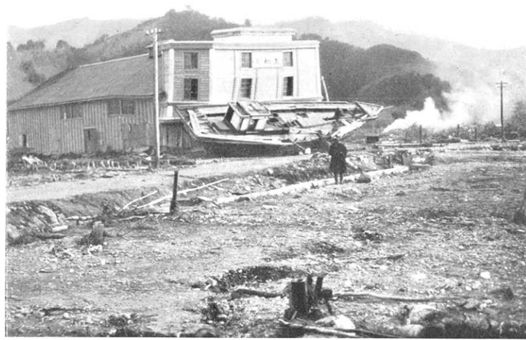
第 270 圖 大槌町 大槌町海岸附近活動小屋に衝突して正面入口を破壊せる大型漁船、此の附近にありし家、納屋は皆流失せり。(3月8日高橋撮影)
