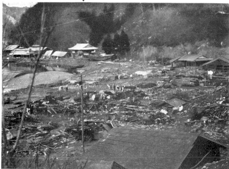
第 286 圖 釜石町蟬石. 蟬石町の惨状, 寫真中矢印の家の土壁に浸水の 高さを示す跡あり. (3 月 6 日高橋撮影)
