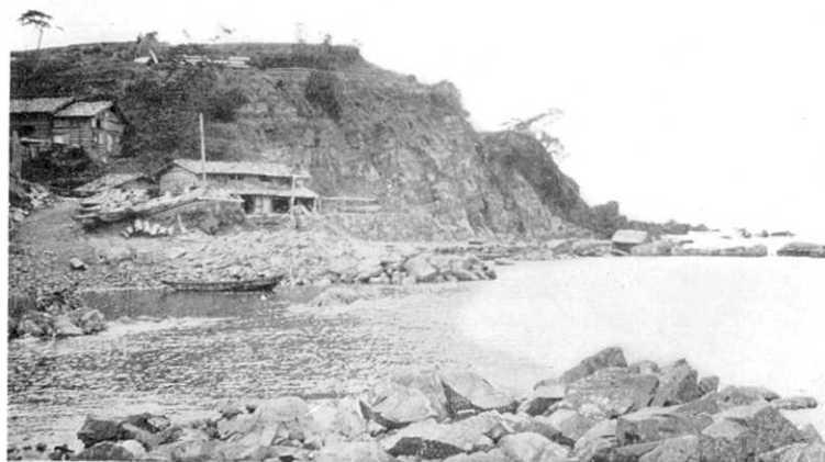
第 393 圖 十五濱村大須。海中に暗礁多き爲か外洋に面してゐる割合に浪高低く最下位の納屋に少しく浸水したるのみ浪高 3.8 米。(5 月 21 日 高橋撮影)
