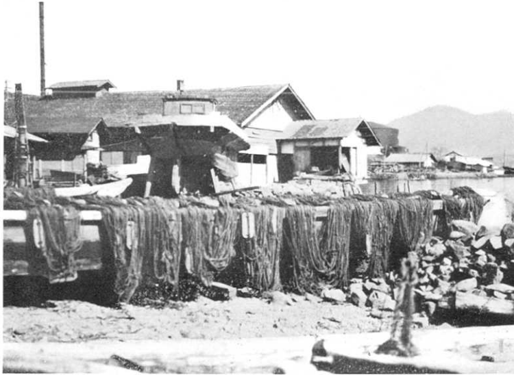
第 329 圖 大船渡町平. 浪高 2.8 米. 大型漁船陸に上げらる. 家は相當に浸水したが, 羽目を破られた程度にて倒潰せず. (4 月 14 日高橋撮影)
