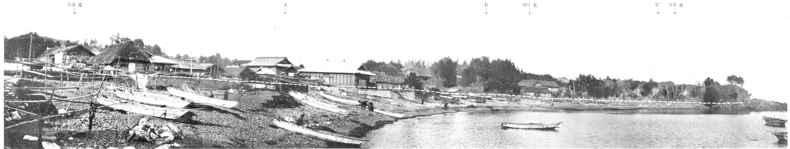
第 334 圖 末崎村泊里。圖中 dotted line は津浪最高點の跡を示めてゐる。そして圖上の矢でその附近での浪高を示めず。泊里部落は概して浪高は 6 米である。A 附近では 4 軒家がその場に倒壊され、B 附近では死者 8 人を出し、人家が 12 軒山の手の方に流されてゐる。そして C の附近では 3 軒の家が流失してゐる。(4 月 30 日西村、高山撮影) Fig. 334. Tomari, Matuzaki village. Dotted line shows heights reached by tsunami; the same for particular points indicated by arrows; on the average about 6 m. Near A four houses overturned; near B twelve houses were washed away toward the hill, resulting in 8 persons killed; near C three houses were washed away. (Photo by G. Nishimura and T. Takayama, April 30.)
