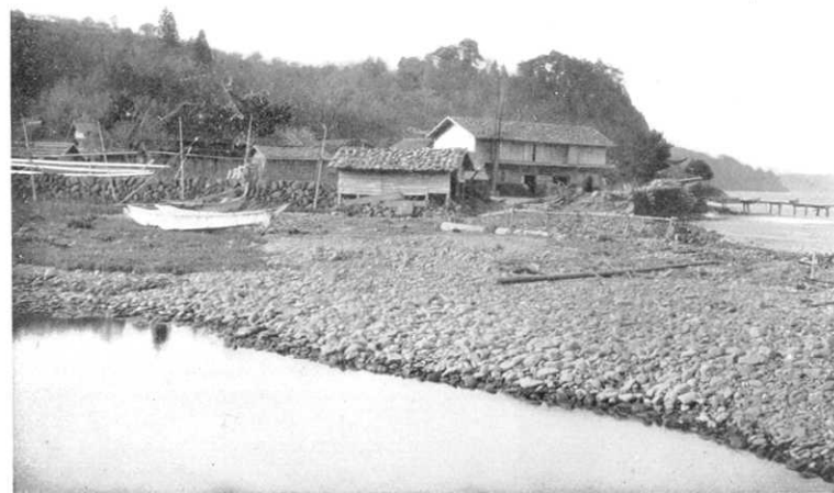
第 378 圖 戸倉村折立海岸. 寫眞中央の小屋羽目を破らる. 浪高 2.7 米. (5 月 20 日 高橋撮影)
