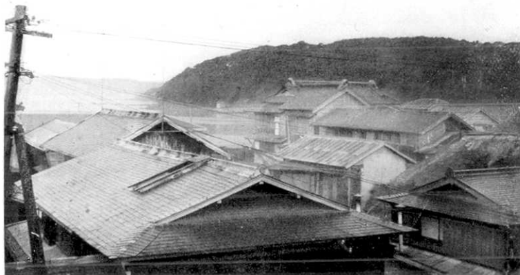
第 405 圖 鮎川町。向側山際に白く見ゆるは検潮所。此邊一帯は海岸に 護岸工事ある爲被害なし。浪高 2.3~3.2 米。(5月23日高橋撮影) Fig. 405. Aikawa-mati. A tide-gauge station, centre of photo. (Photo by R. Takahasi, May 23.)
