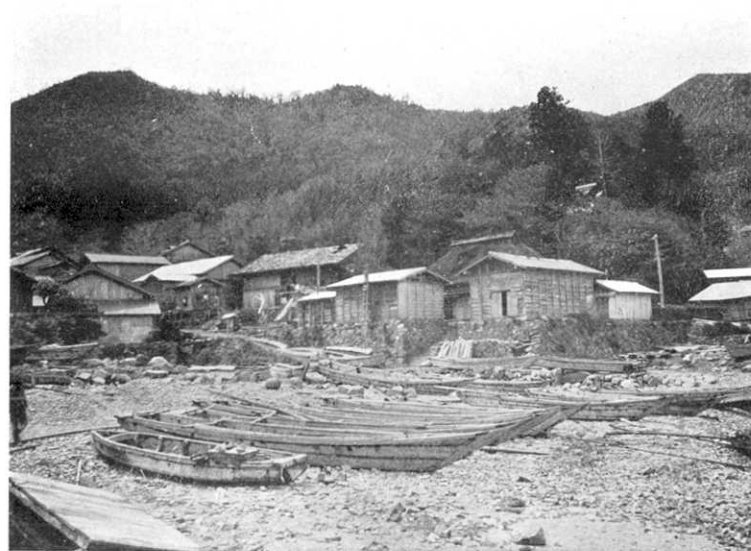
第 394 圖 十五濱村熊澤。津浪は寫眞右手の石垣の上端まで届いた海面上 7.3 米。(5 月 22 日 高橋撮影)
