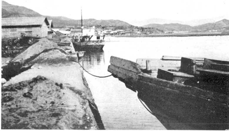
第 327 圖 大船渡町缺の下. 海岸にある倉庫に少々浸水したれ共言ふ程の被害なし. 写真右端の平坦地は盛町につゞく田圃であつて海岸から1軒以上浸水せり. 其左の部落は赤澤. (4月14日高橋撮影) Fig. 327. Kakenosita, Oohunato-mati. No serious damage. (Photo by R. Takahasi, April 14.)
