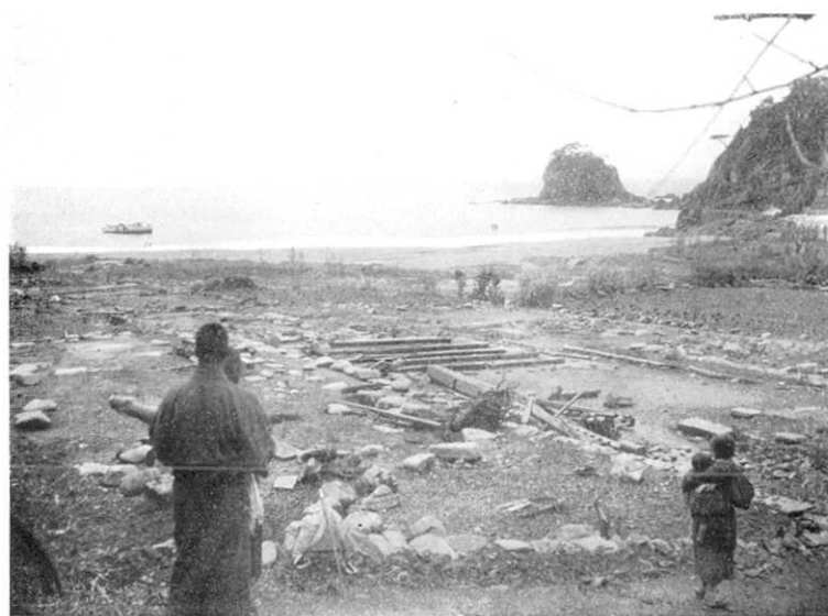
第 388 圖 十五濱村荒屋敷。最も激しく津浪に襲はれたる部落の 1 つ。家は大半流失又は倒壊し後には土臺のみ残り浪高 11 米餘。(5 月 22 日 高橋撮影)
