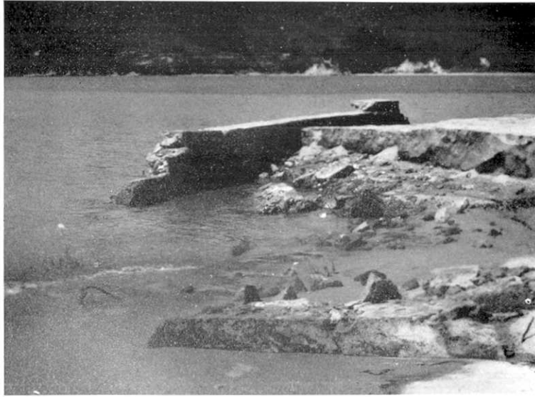
第 264 圖 田ノ濱村. 護岸堤防破壊せらる. (木村撮影)
