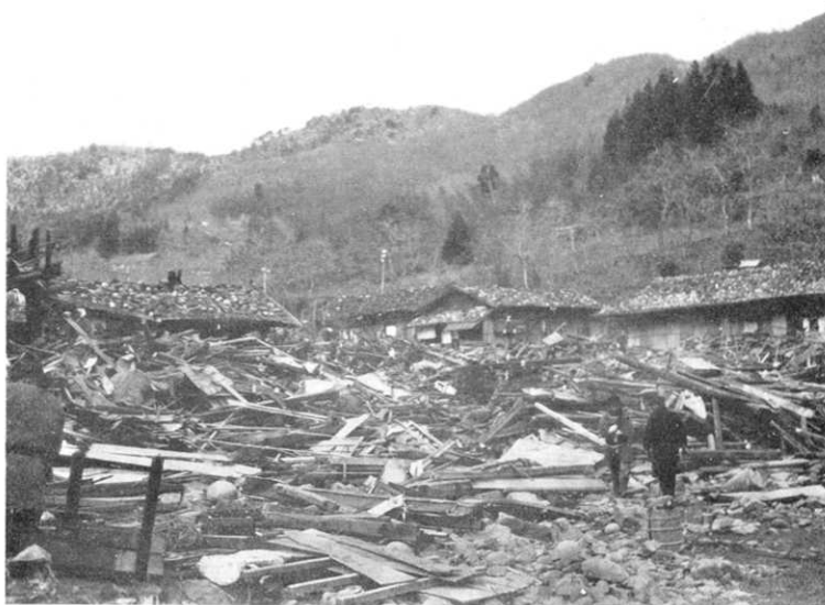
第 292 圖 唐丹村小白濱. 小白濱部落北寄の部分(學校下)破壊せる家の柱, 羽目板等の山積せる狀況. (3 月 6 日高橋撮影)
