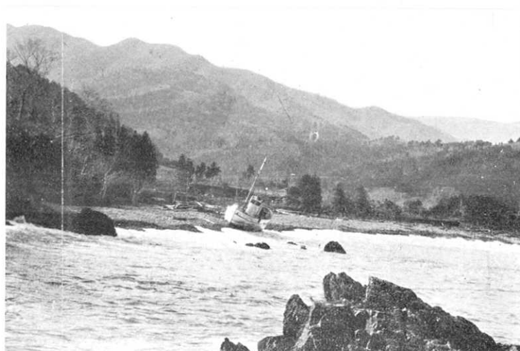
第 304 圖 越喜來村下甫嶺。船の後の濱にありし製造工場悉く流失して土臺のみ残り。 (4 月 11 日 高橋撮影)
