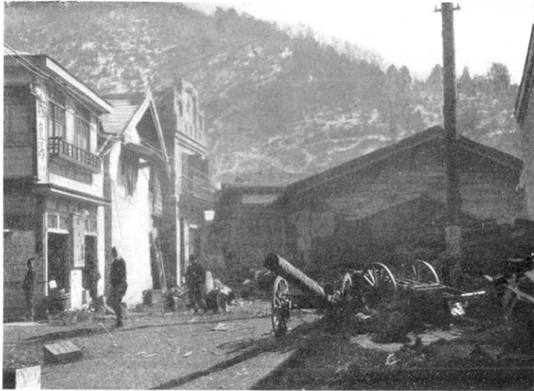
第 276 圖 釜石町東端. 2 階建家屋倒壊して道路を閉塞す. (3 月 7 日 高橋撮影)
