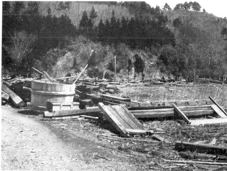
第 322 圖 赤崎村清水。大船渡灣の東沿岸多くは海岸のみ 浸水したるも此の様な谷がある所は奥まで浸水せり。此の谷にありし家破壊せられたり。(4 月 13 日高橋撮影)
