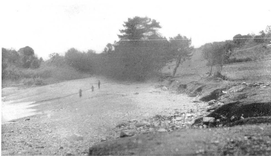
第 354 圖 唐桑村砂子馬場。海岸竝木附近にあつた 2 米あまりの高さをもつた石柵を跡かたもなく津浪は洗ひ去つてゐる。6 度位の傾斜地であり且つ外洋に面してゐるので浪高も大きく 11.2 米、海岸にあつた家がさらはれた。(4 月 25 日西村、高山撮影)
