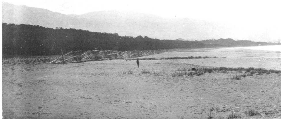
第 343 圖 高田松原. 廣田灣の灣奥に位する砂濱である. 松林の前方にある松苗の柵は津浪の爲め破壊されてゐる. (3 月 28 日西村, 高山撮影)
