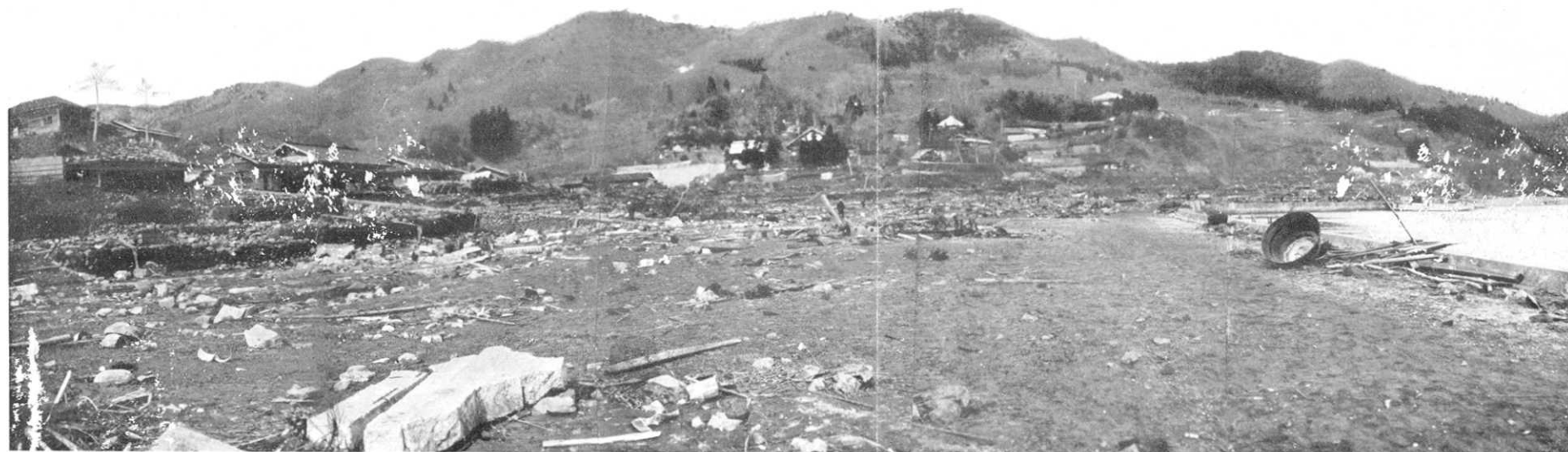
第 291 圖 唐丹村小白濱 海岸側の家 3 列流失す、混凝土の護岸の一部破損せり、寫真左下のものは其の破片なり、寫真矢印の交點に津浪の浸水の跡 1 直線に残れり、此の高さ平均海面上 11.8m。(3 月 6 日高橋撮影)
