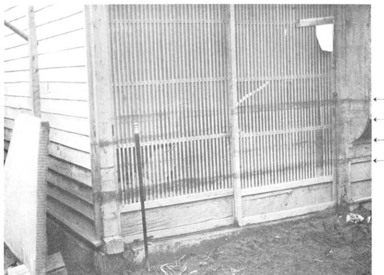
第 272 圖 釜石町貝越. 鯨粕の油による数條の津波の跡. (3月5日高橋撮影) Fig. 272. Tadakosi, Kamaisi-mati. Height marks left by successive tsunamis. (Photo by R. Takahasi, March 5.)
