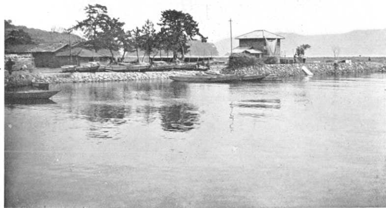
第 377 圖 志津川町東端河口附近. 寫眞に矢印にて示せる家は地盤低き爲床 50 程程浸水せり. 浪高平均海面上 1.3 米 2 階建家の後方は埋立地. (5 月 20 日 高橋撮影)
