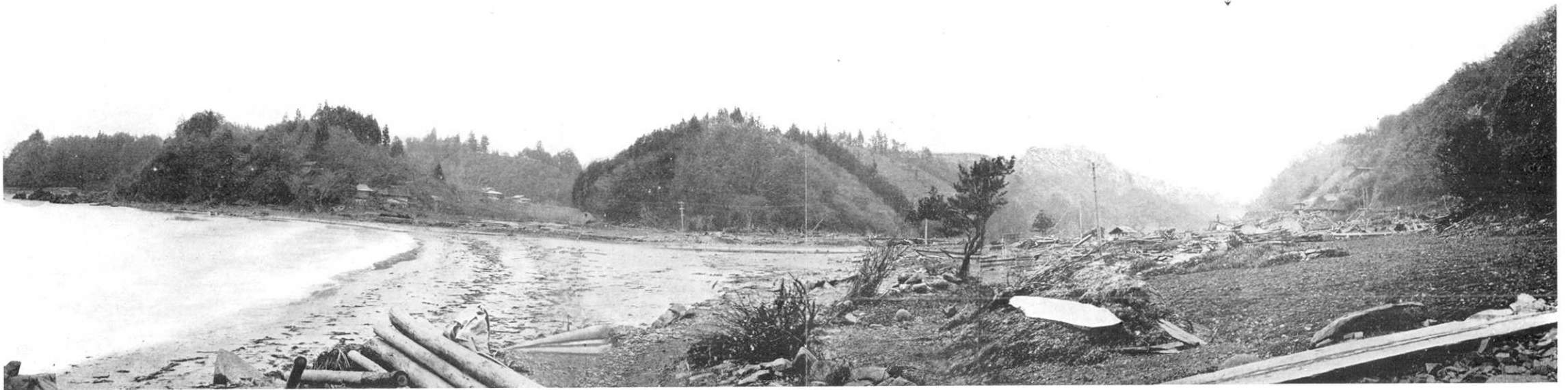
第 363 圖 小泉村廿一濱。此の附近にて最も被害甚大なる所、部落は殆んど皆倒潰又は流失せり。津浪は矢印下の谷に沿ひ海岸より約 600 m 浸入す。浪高海岸にて 6 米。(5 月 18 日高橋撮影)
