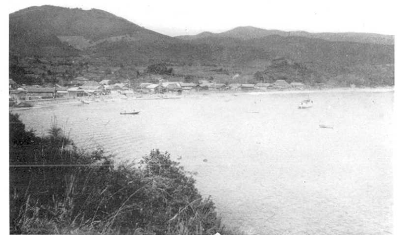
第 403 圖 鮎川村十八成。此の部落は被害皆無。津浪の高さは2米餘なるも海岸に2米餘の護岸あるを少々越したる程度なり。(5月23日高橋撮影) Fig. 403. Aikawa-mati, Kugunari. Wave height only about 2 m and just about washed top of sea wall. No damage. (Photo by R. Takahasi, May 23.)
