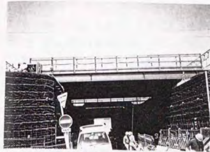
写真-3.2.1 仮桁設置時全景 (名古屋)
