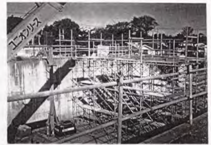
写真-3.1.2 実物大水平載荷試験状況
