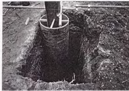
写真-3.1.3 盛土内支柱の構築状況
