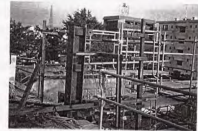
写真-3.1.4 壁頂支柱の構築状況
