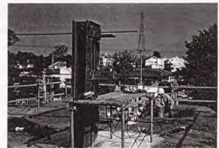
写真-3.1.6 反力支柱へのジャッキの取り付け
