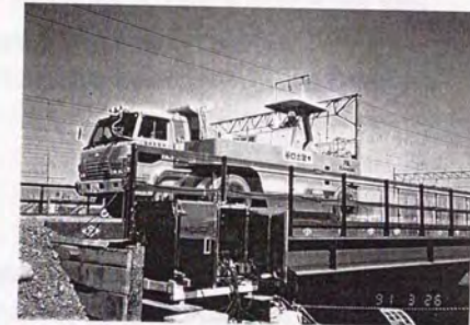
写真-3.2.4 走行試験計測状況 (名古屋)
