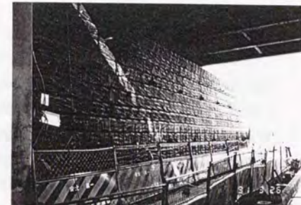
写真-3.2.2 仮桁設置時桁下 (名古屋)
