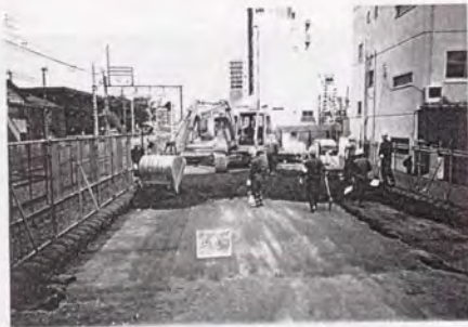
写真-4.1.9 盛土材の撒き出し状況
