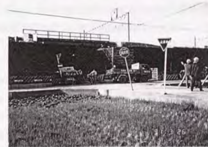
写真-4.2.14 橋台部仮桁設置
