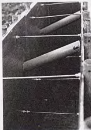
写真-4.1.14 排水パイプの取付状況
