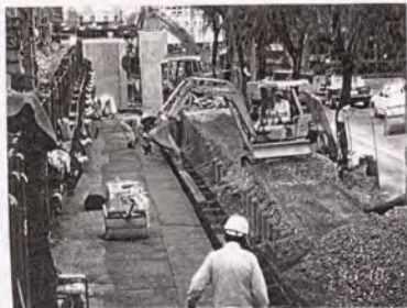
写真-4.3.1 エキスパンド箱による施工状況
