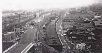
写真-4.2.3 電留線部土壌積み上げ状況
