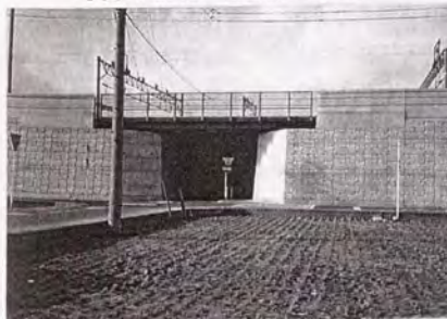
写真-4.2.15 橋台部完成状況
