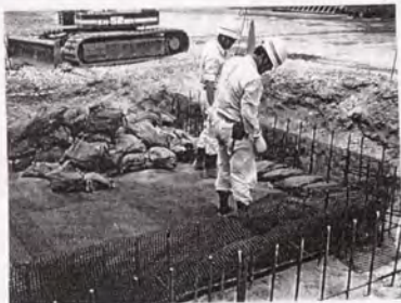
写真-4.3.3 計測部橋台施工状況 (橋台No. 3)
