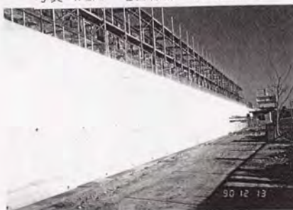
写真-4.2.7 資材置場完成状況
