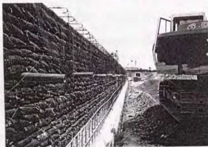
写真-4.2.6 資材置場施工状況
