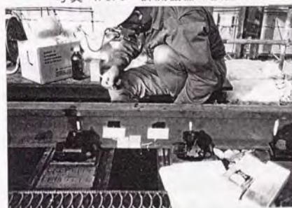
写真-4.3.11 レールひずみ計の取付け状況
