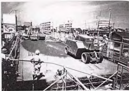
写真-4.1.10 盛土の転圧状況
