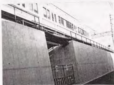
写真-4.3.7 橋台部完成状況 (橋台No. 2)
