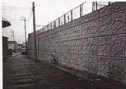
写真-4.2.8 保守基地線部完成状況
