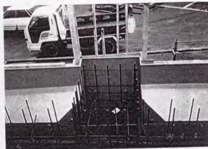
写真-4.1.12 電柱基礎部の型枠設置状況
