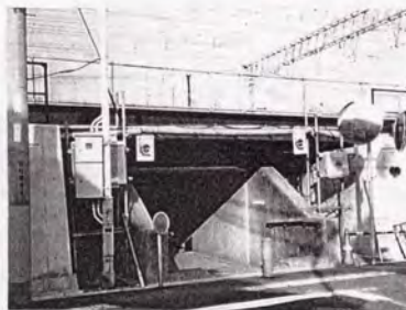
写真-4.3.6 橋台部完成状況 (橋台No. 1)
