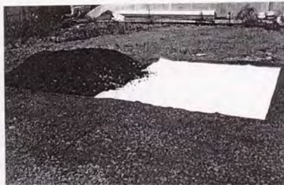
写真-3.6.6 施工試験2 (補強材敷設、撤出し)
