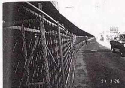
写真-4.2.9 電留線部施工状況
