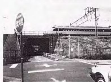
写真-4.2.11 橋台部施工前
