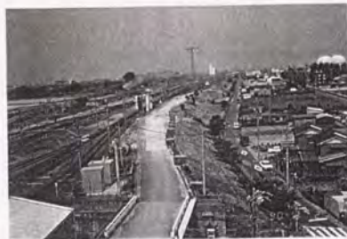
写真-4.2.1 電留線部施工前全景
