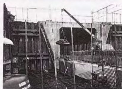
写真-4.2.12 橋台部基礎部施工
