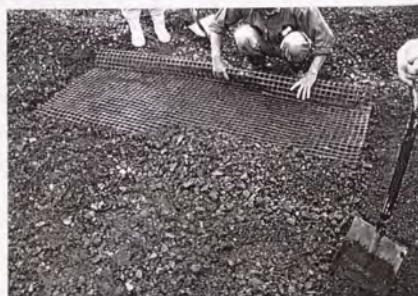
写真-3.6.8 施工試験4 (ジオテキスタイル回収)
