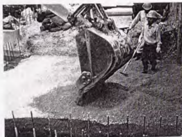
写真-4.3.4 計測部橋台施工状況 (橋台No. 1)
