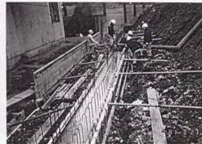
写真-4.1.2 基礎工の施工状況
