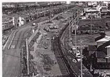
写真-4.2.2 電留線部補強材敷設
