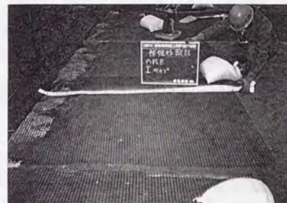
写真-4.1.3 ジオテキスタイルの敷設状況
