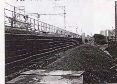
写真-4.1.8 籠による仮抑え状況
