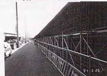
写真-4.1.6 土嚢による仮抑え状況
