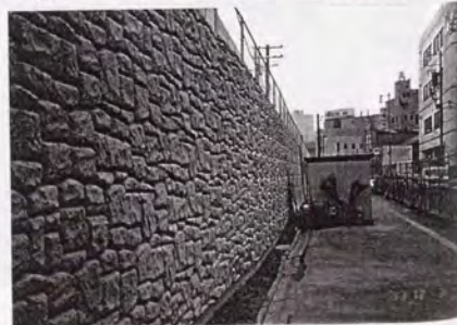
写真-4.1.15 完成状況
