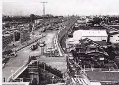
写真-4.2.4 電留線部補強土擁壁完成
