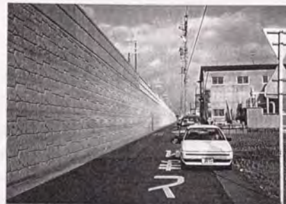
写真-4.2.10 電留線部完成状況
