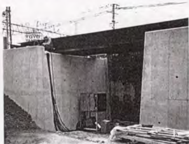
写真-4.3.5 計測部橋台完成状況 (橋台No. 3)
