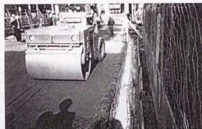
写真-4.1.5 土嚢部近傍の締固め状況
