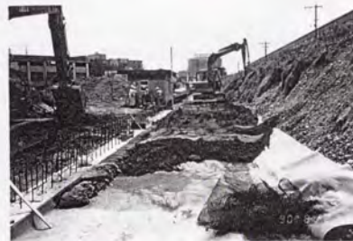
写真-4.1.1 基礎面の排水対策
