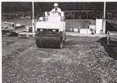
写真-3.6.7 施工試験3 (クラッシャーランの転圧)
