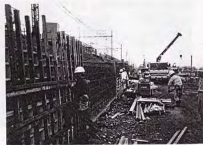
写真-4.1.13 一般壁面部の型枠設置状況
