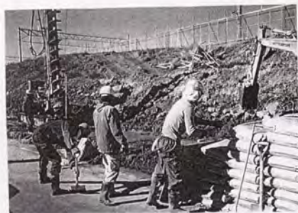
写真-4.2.5 電留線部一部地盤改良
