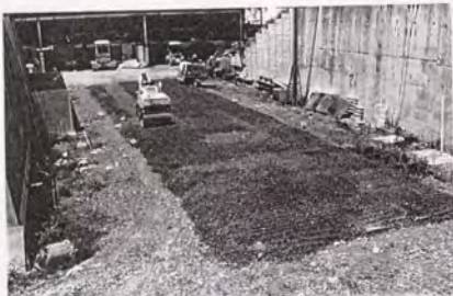
写真-3.6.5 施工試験1 (施工面の転圧)
