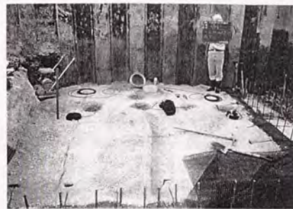
写真-4.3.9 計測機器の設置状況
