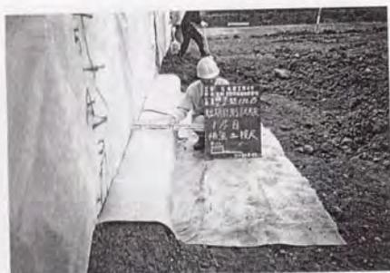
写真-4.5.18 試験盛土補強材の設置状況
