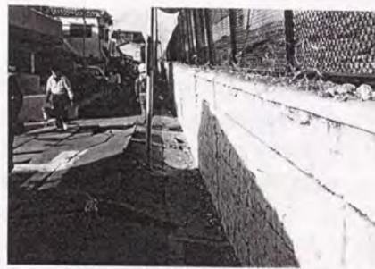
写真-4.6.10 補強土擁壁前面のアスファルト隆起
