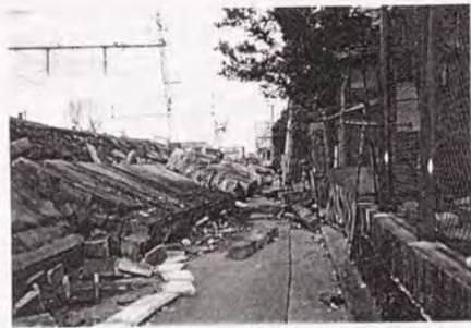
写真-4.6.1 もたれ壁の被害状況（住吉地区）
