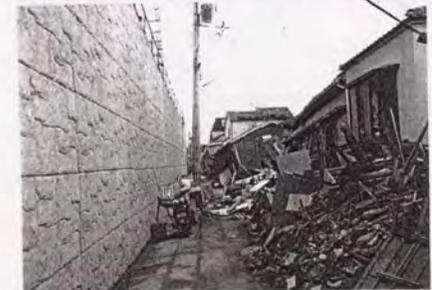
写真-4.6.7 補強土擁壁周辺の家の倒壊状況（タナタ地区）
