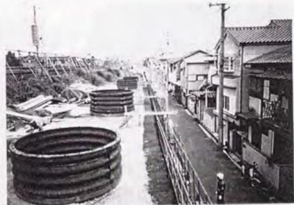
写真-4.7.5 タナタ電柱基礎の施工, No. 5, 1990
