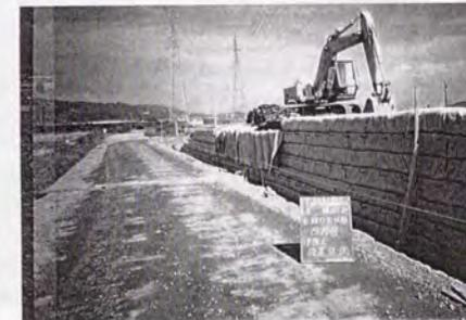
写真-4.5.12 本体計測部の土壌積上げ
