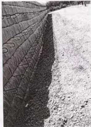
写真-4.5.5 補強土擁壁の沈下状況
