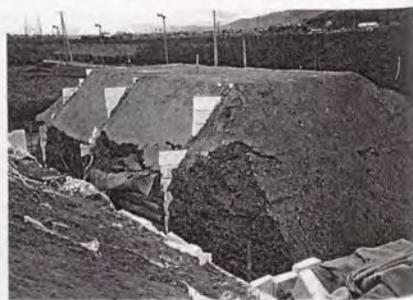
写真-4.5.23 EPS引抜き直後の変形状況
