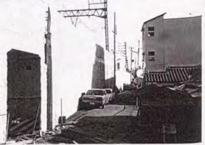
写真-4.6.8 補強土擁壁とボックスとの目違い
