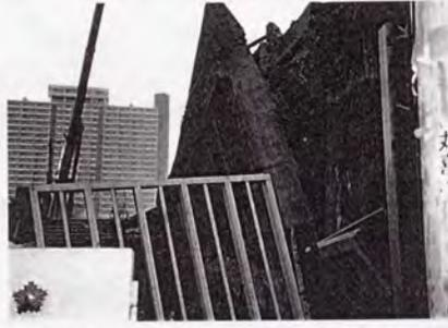
写真-4.6.4 逆T型擁壁の壁体破壊（新長田地区）
