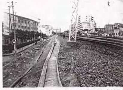
写真-4.6.2 張りブロックの滑落（住吉地区）
