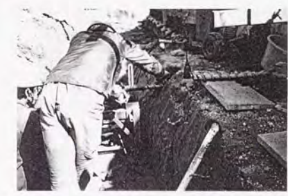
写真-5.2.3 先受けボルトの施工状況
