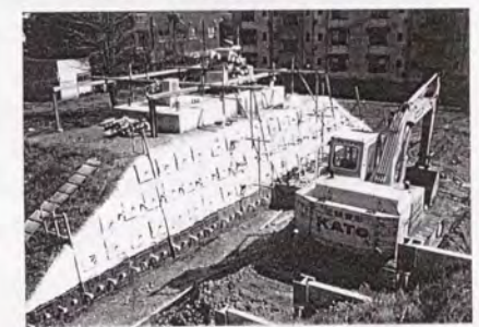
写真-5.2.6 施工中の起振実験状況
