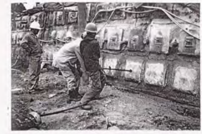
写真-5.2.1 ハンドオーガーによる削孔状況
