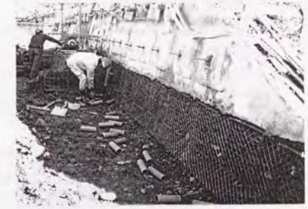
写真-5.2.4 掘削面のラス網設置状況
