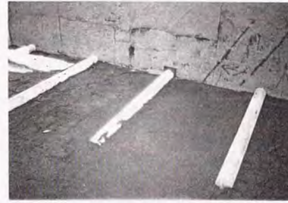
写真-5.1.16 相似率実物大実験：補強材の設置
