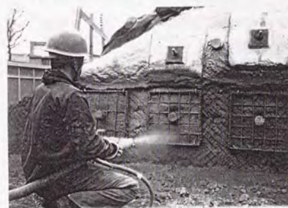
写真-5.2.5 吹き付け状況
