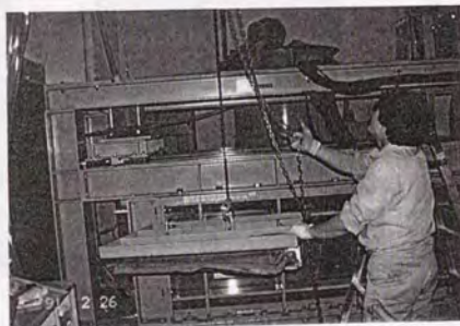
写真-5.1.12 クリープ実験：エアバック設置状況
