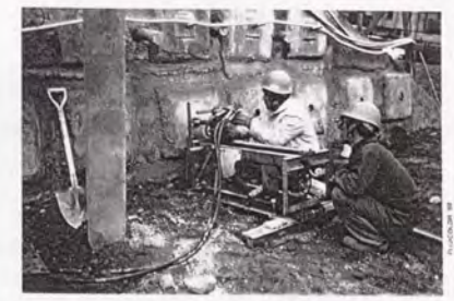
写真-5.2.2 簡易削孔機による削孔状況
