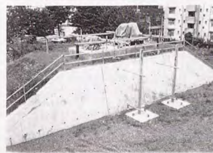
写真-5.2.7 施工完成状況
