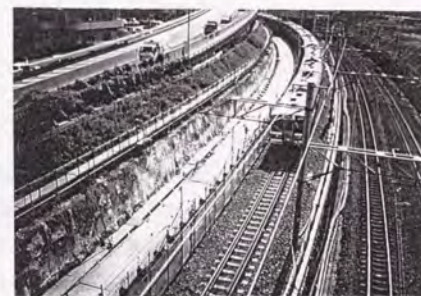
写真-6.2.10 本体部掘削終了
