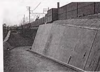
写真-6.3.5 完成状況
