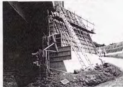
写真-6.3.4 壁面の型枠取り付け
