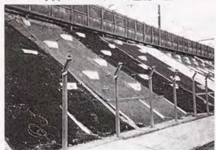
写真-6.5.7 試験施工の完成状況
