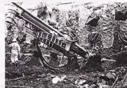
写真-6.4.2 大径補強体の施工状況（高架橋部）
