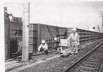
写真-6.3.7 変位計の設置状況
