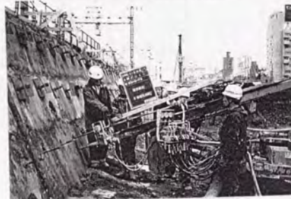
写真-5.5.4 補強材の打設
