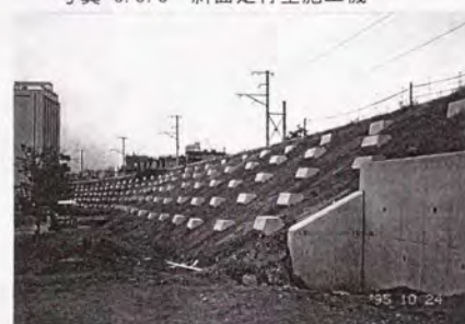
写真-6.5.8 震災での盛土復旧状況 (JR貨物、瀬駅付近)
