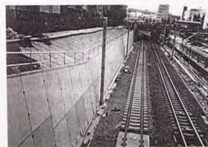
写真-6.2.13 完成状況（池袋方面）
