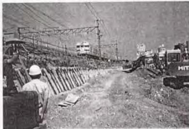
写真-5.5.3 掘削状況
