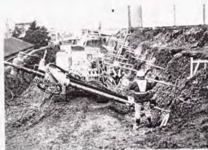
写真-6.3.2 大径補強体の施工
