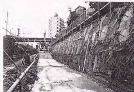
写真-6.2.9 本体部の掘削状況
