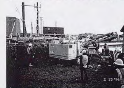
写真-6.6.7 1段掘削施工状況 (青森No. 18)
