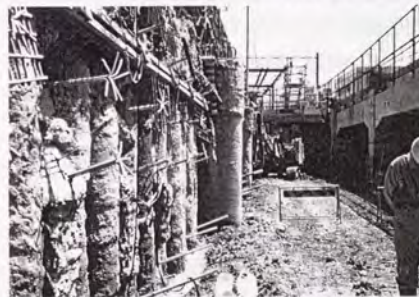
写真-6.4.3 掘削完了（橋架橋部）
