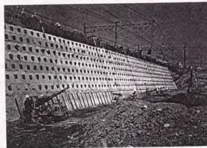
写真-5.5.6 掘削終了
