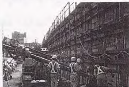
写真-6.2.6 仮土留め最終段の施工
