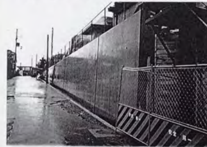
写真-6.6.3 復旧完成 (驛駅構内No. 11)
