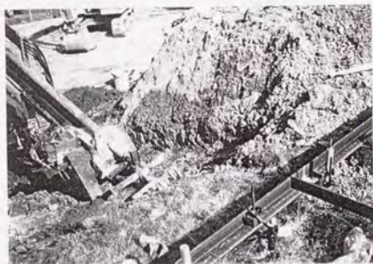
写真-5.6.5 施工中の変形計測状況
