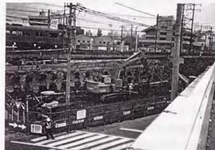
写真-6.4.1 大径補強体の施工状況（歩道橋部）
