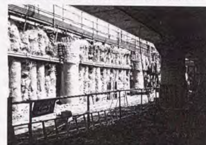
写真-6.4.4 掘削完了（高架橋部）
