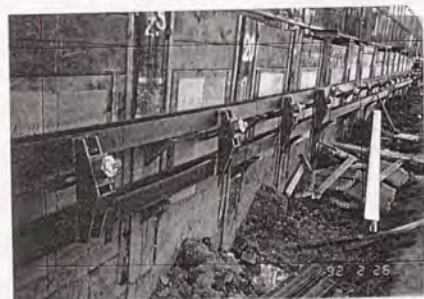
写真-6.2.5 仮土留め定着部
