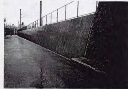
写真-6.6.4 復旧完成 (住吉付近No. 10)
