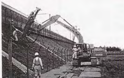
写真-6.5.5 アーム型施工機
