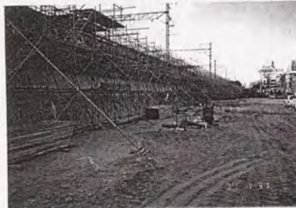
写真-5.5.7 壁面工打設
