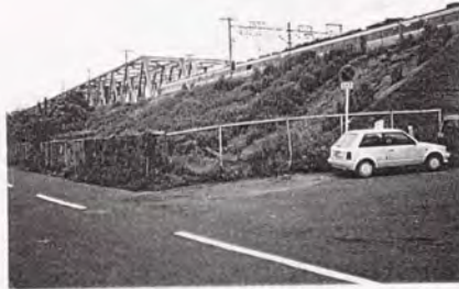
写真-5.5.1 施工前の状況
