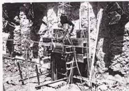
写真-6.4.5 引抜き試験状況
