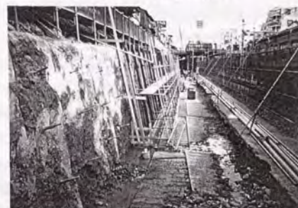
写真-6.2.12 壁面工の施工
