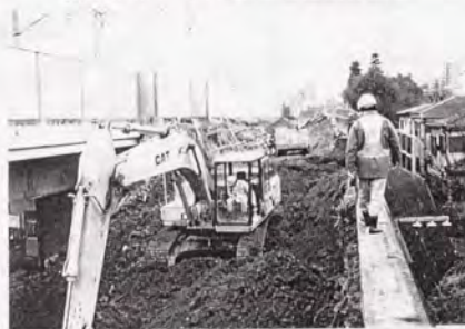
写真-6.3.3 盛土の掘削状況
