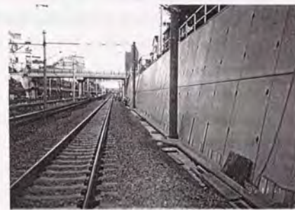
写真-6.2.14 完成状況（大塚方面）
