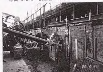
写真-6.2.8 施工時の変形計測状況
