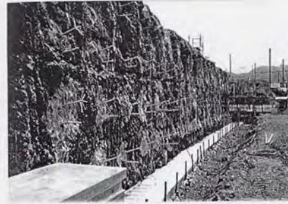
写真-6.6.1 施工状況 (六地蔵駅No. 4)
