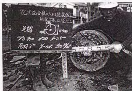
写真-5.6.6 掘り起こされたアンカー体
