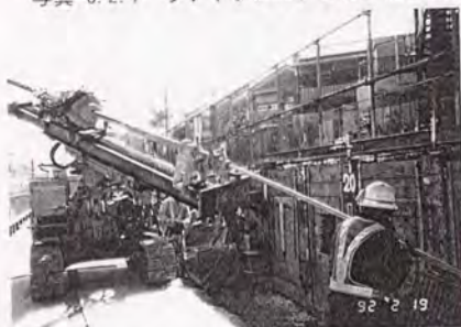
写真-6.2.3 芯材の装着
