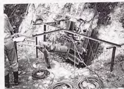
写真-6.3.6 引抜き試験
