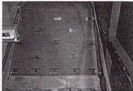
写真-6.5.2 補強土工の散水実験前
