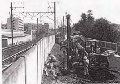
写真-6.3.1 鉛直地盤改良杭の施工
