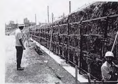
写真-6.6.5 擁壁復旧施工状況 (神戸港付近No. 14)
