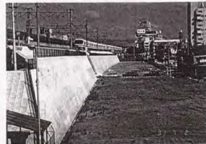
写真-5.5.8 完成状況
