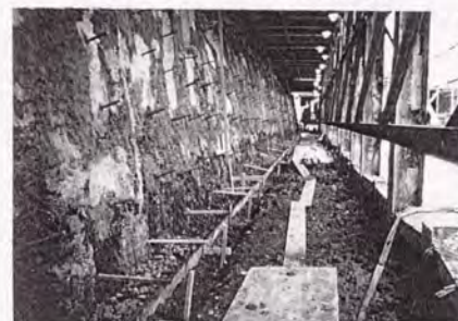
写真-6.2.11 壁面工基礎部の施工
