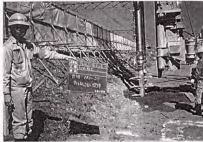
写真-5.5.2 攪拌混合杭の施工
