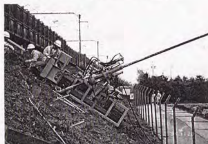
写真-6.5.6 斜面走行型施工機
