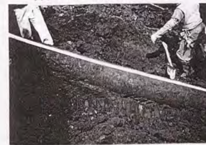
写真-6.2.15 大径補強体の掘り起こし状況
