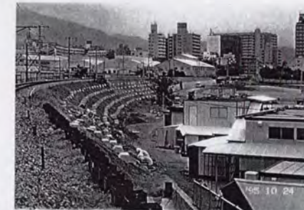
写真-6.6.6 盛土補強施工状況 (神戸港付近No. 14)
