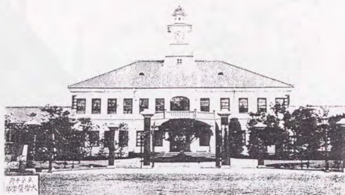
医・本館、M14頃（堀越三郎、明治初期の洋風建築）
