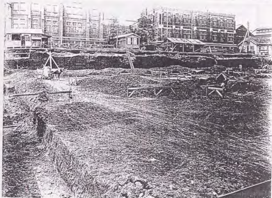
工2建設現場より工・造船側を見る T10.8頃 (施設部蔵、写真縦1921-1923)
