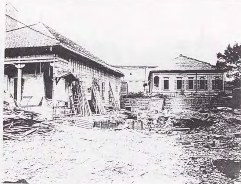
工4現場 T13頃 (乾・工)
