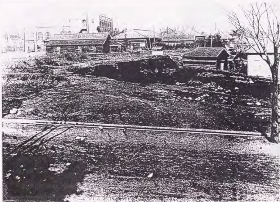
工2建設現場より北側を見る T10.2頃 (施設部蔵、写真縦1921-1923)
