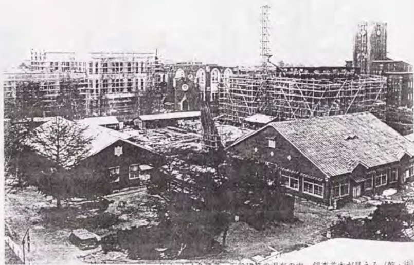
S.3. 法文1と八角講堂。仮設建築の混在の中、銀杏並木が見える (乾・法)
