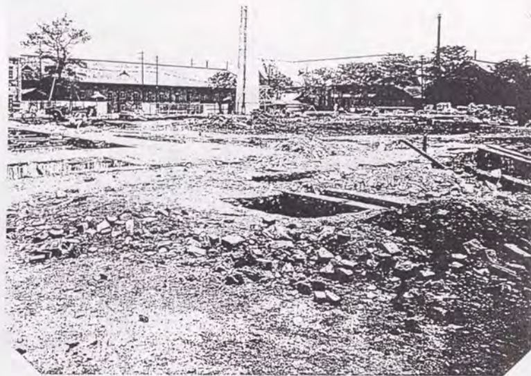
工1号建設現場 S4.5. 背後に応化、実験室群 (施設部蔵、工1号館新営の内基礎及鉄骨工事写真綴)
