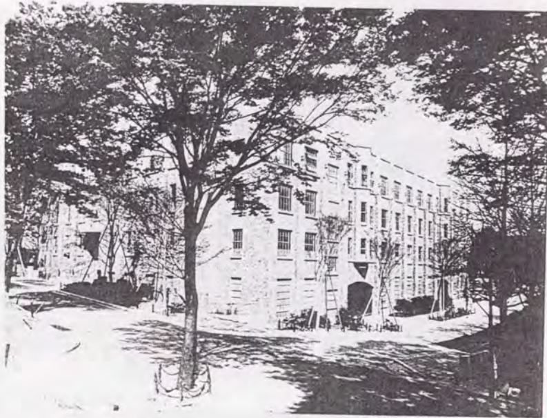
工6号館東側 S14.年頃 (乾・工)
