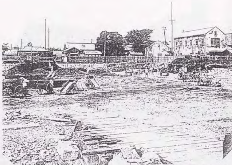
工1号建設現場 S4.7. 西側本郷通り方向を見る (施設部蔵、工1号館新営の内基礎及鉄骨工事写真綴)
