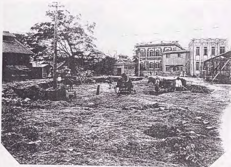
理・本館跡地 T13 (施設部蔵、東京帝国大学理・物理学教室及共通講義室新営工事写真帖、T13.6.~T15.5.)
