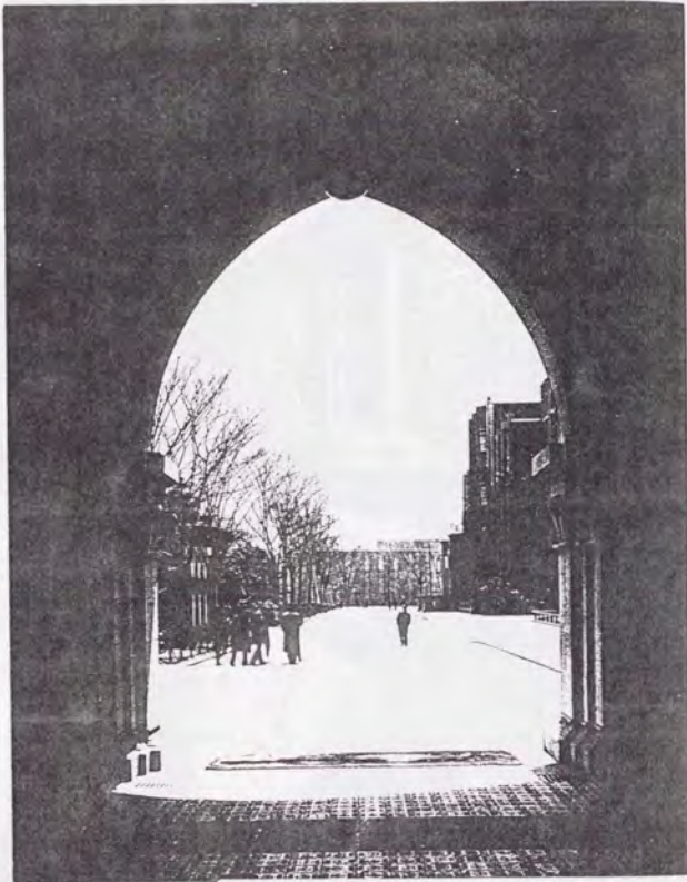
法文2アーケードより南を見る S14.4. (乾・法)
