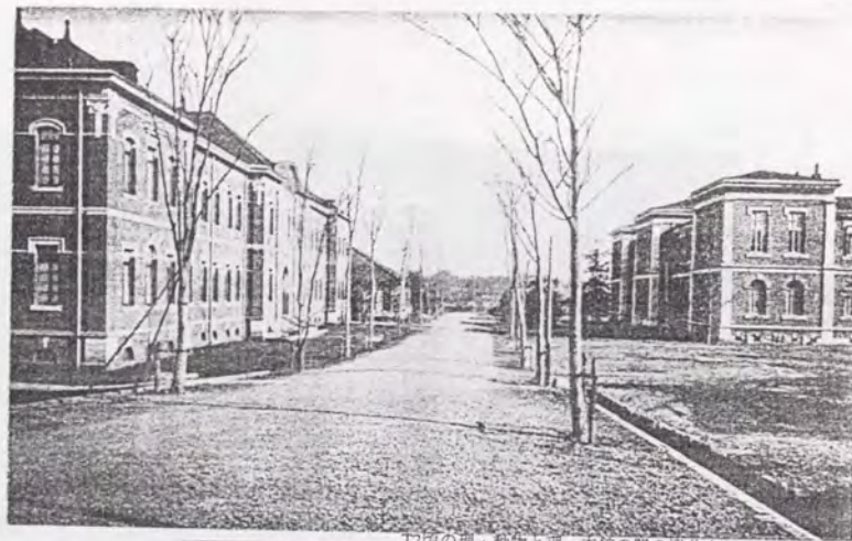
理の館・動物館・本館の間の植樹帯 (同大学・新)
