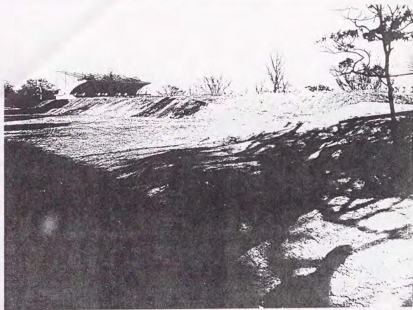
農・地区トラック整備前 S14.年頃 (乾・農)
