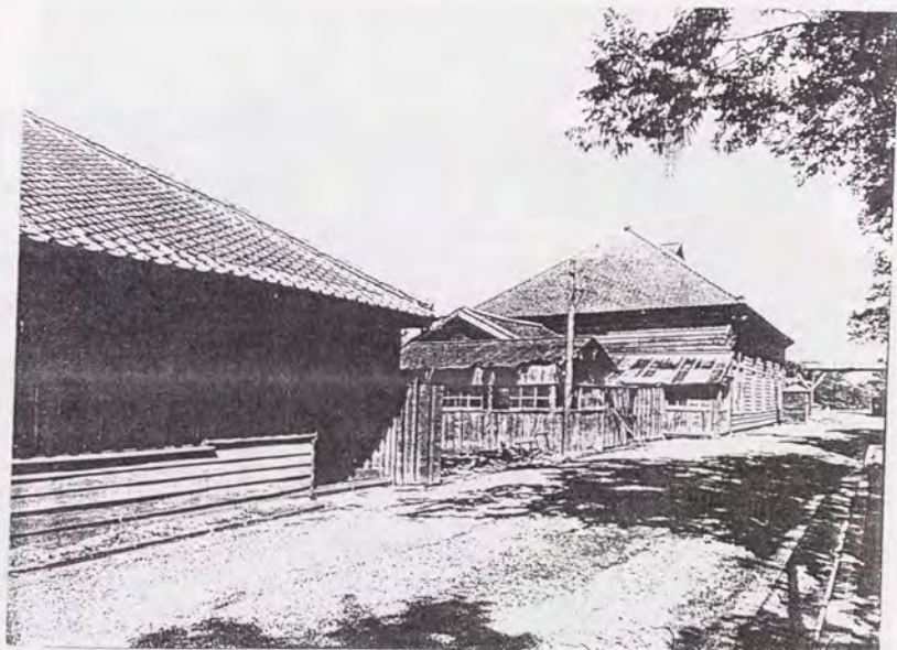
同上池之端門への街路沿い部分(同上)
