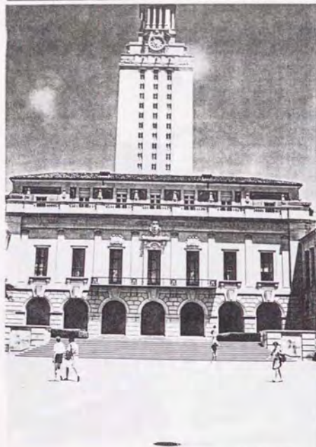
UTタワーと前面広場
