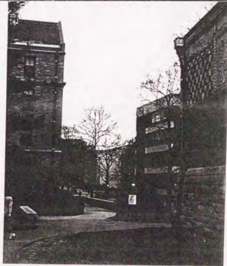
同地区オースチンホールの北側
