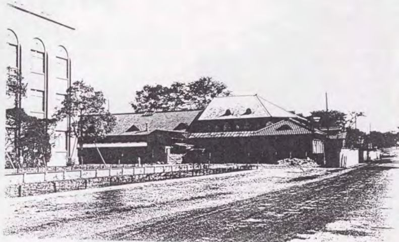
病院通り 電線の埋設 S5.8 (乾・震災)
