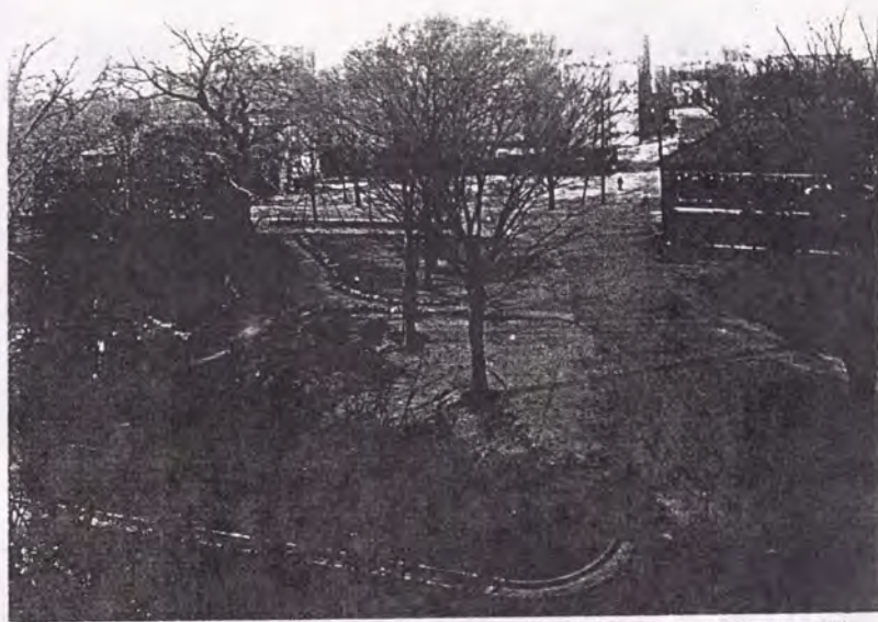
椿山東側と医・本館付近を北に向き見る 右に医・法医が残る S13.12. (乾・震災)
