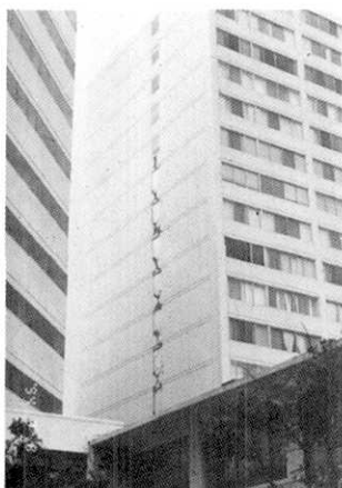
写真 49 妻面のつなぎ梁にせん断ひび割れ
