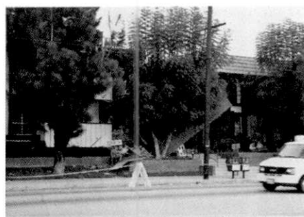
写真 57 住宅のレンガ造煙突の倒壊 (Northridge 地区)
