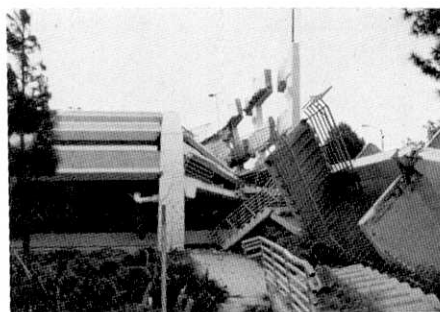
写真2 北外構面柱コーベルから梁が脱落
