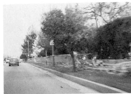
写真 58 無筋のブロック塀の転倒崩壊 (Northridge 地区)
