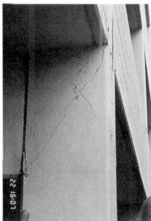
写真 25 ト形接合部にせん断ひび割れ
