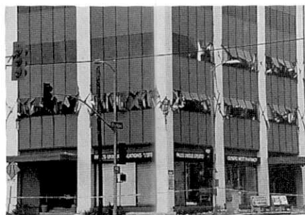
写真43 南西面の2、3階が連層耐震壁のない南東側にはらみ出す（三谷氏提供）
