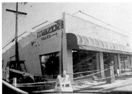
写真 55 1階建てショールームの屋根が落下 (Santa Monica 地区)
