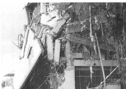
写真 39 隅柱の接合部が破壊し、南のれんが造の妻壁が落下折損
