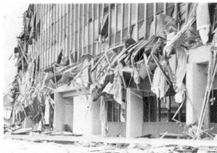
写真 38 2階が層崩壊
