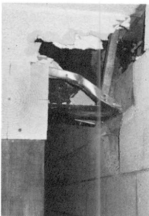
写真 27 大スパンを支えるためのせいが 70~80cm もある鉄骨の梁 (木材は、梁の落下を防ぐために地震後補強されたものである)
