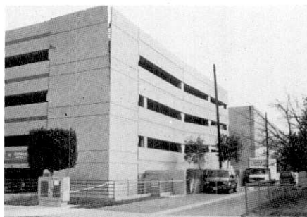
写真14 柱のコーベルの破損および外壁のジョイントが外れて傾斜
