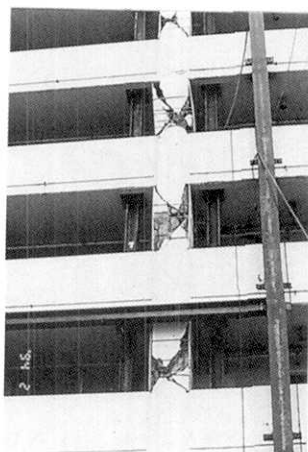
写真 48 短柱のせん断破壊
