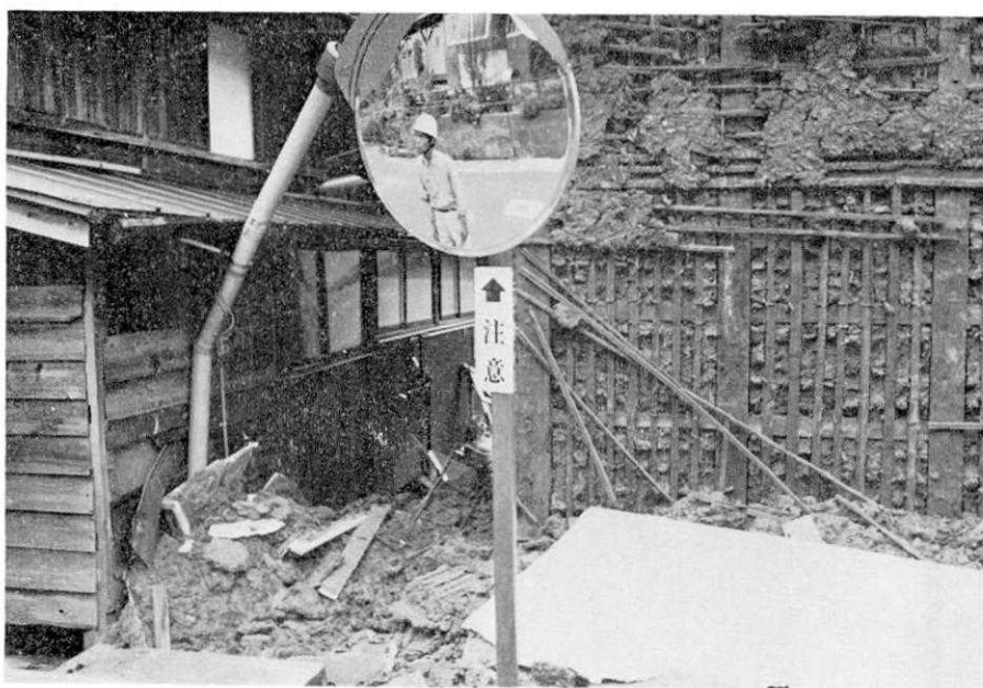
写真 7 塗り壁の落下 (松越地区)
