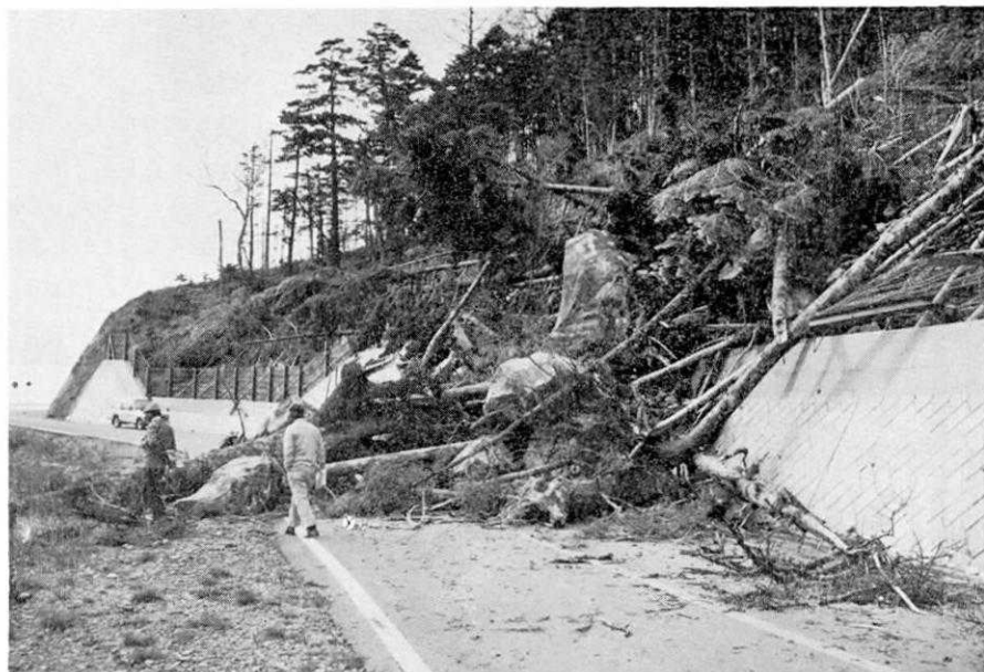
写真 4 防御壁を崩した落石（御岳高原）
