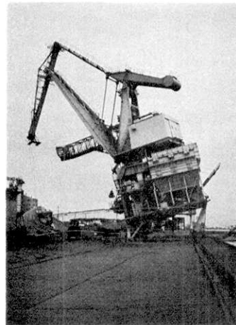
写真 8. 秋田港のクレーンの被害
