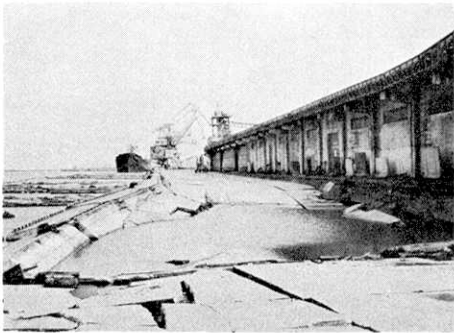
写真 5. 秋田港における地盤の陥没
