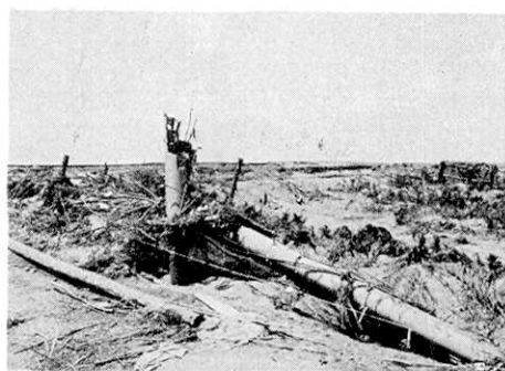
写真10. 津波により折れた電柱
