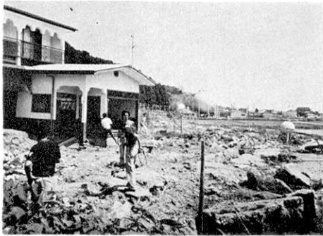
写真16. 若美町の傾いた家屋
