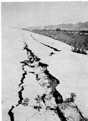
写真18. 八郎潟の堤防の沈下
