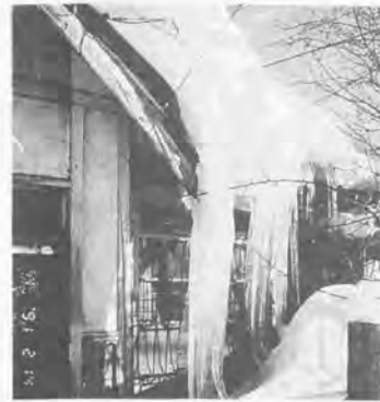
写真 8.2 軒先部の氷柱などの障害の例
