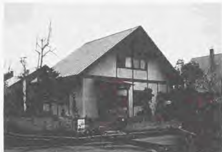
写真 8.1 蟻掛け鉄板による急勾配屋根 (公社型三角屋根住宅)
