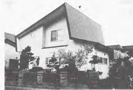
写真 8.4 蟻掛け鉄板によるまねき屋根
