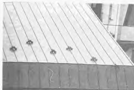
写真 8.5 屋根面の雪止め金物
