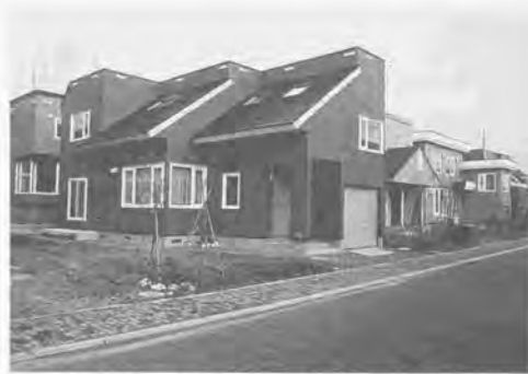
写真 8.12 混合屋根 (勾配屋根+無落雪屋根)
