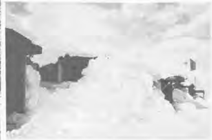
写真 8.3 落雪障害の例
