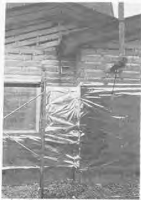
(a) 構造躯体の外側に防湿性の高いシートを施工した例 (写真はダンマツではなく、アルミ蒸着シートを使用したもの)
