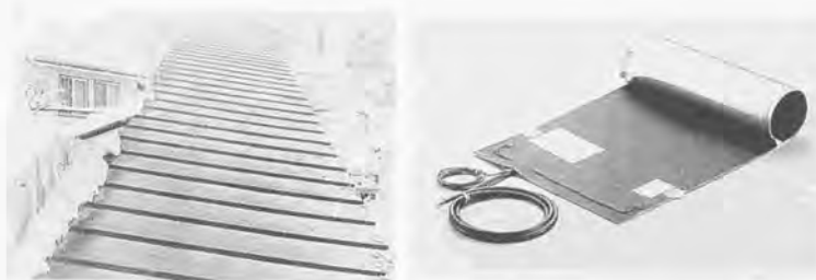
写真 8.14 ルーフヒータ施工例
