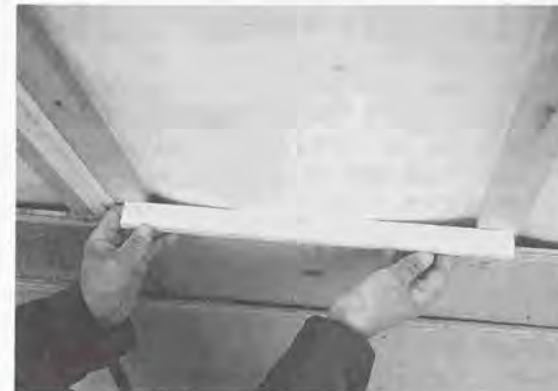
写真 5.2 断熱施工後のシート状防風材の様子
