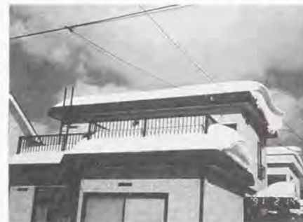
写真 8.10 フラット屋根
