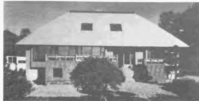
写真 8.9 横葺屋根材を用いた急勾配屋根(筆者らの設計、建設地:北海道虻田町)
